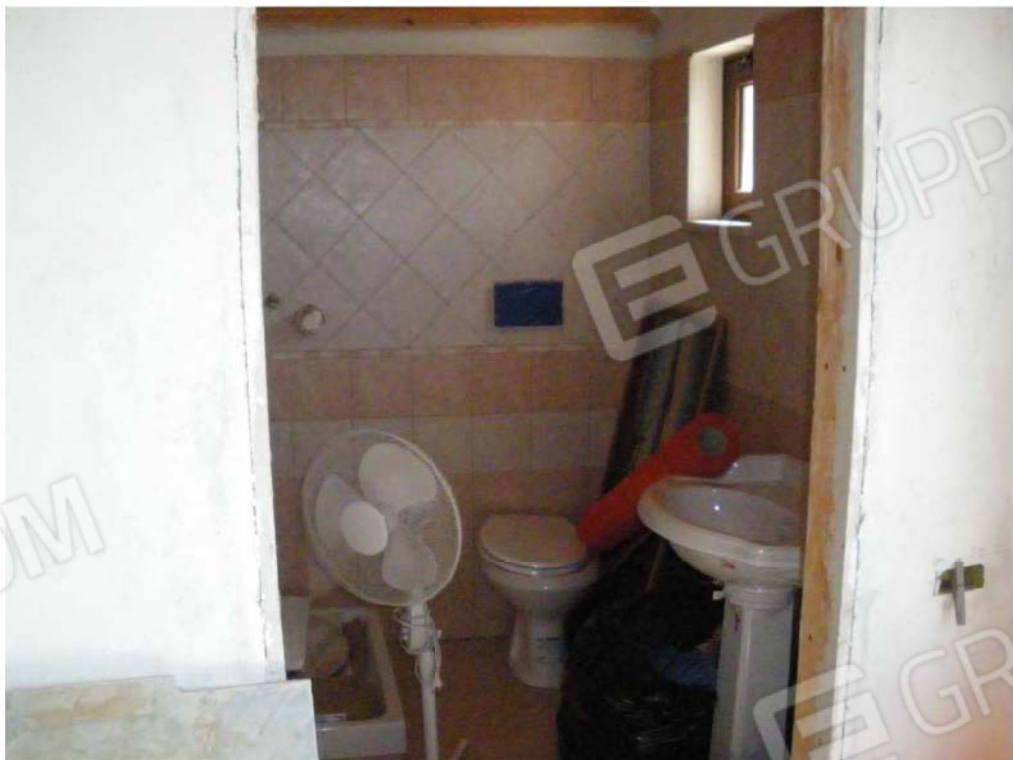
Foto N° 22 – BAGNO IN CORSO DI COSTRUZIONE
