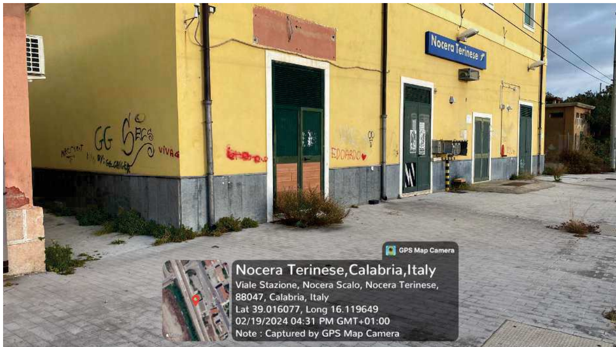
Foto 1 – rilievo del III termine stazione ferroviaria di Nocera Terinese
