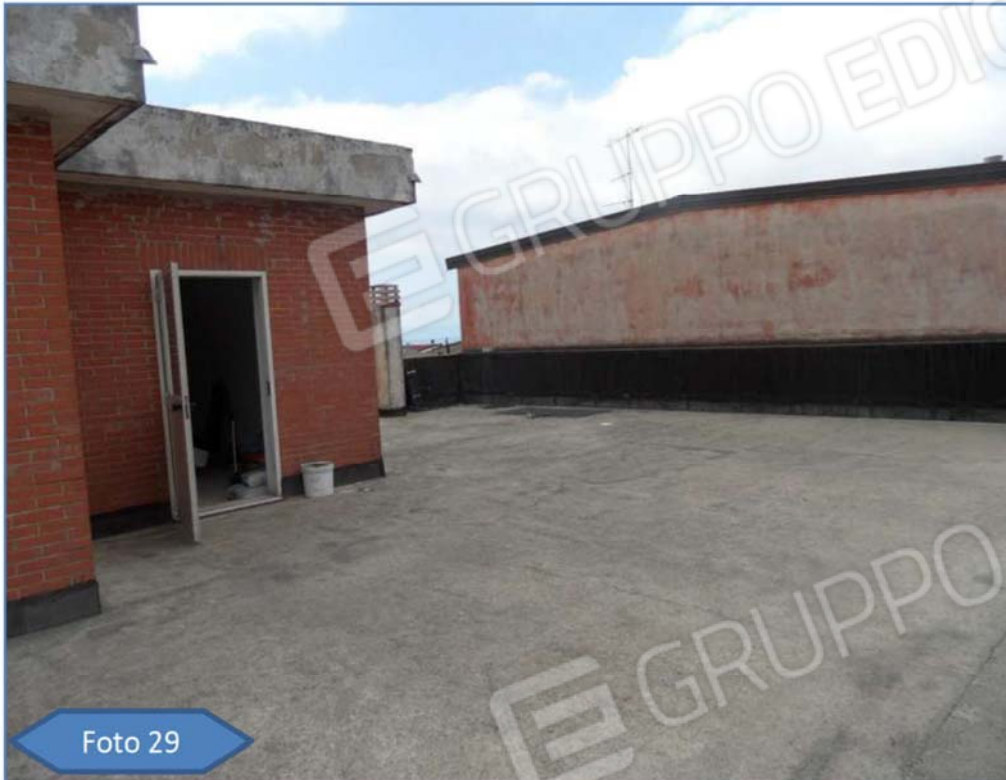
Lotto 1 – Lastrico solare.
