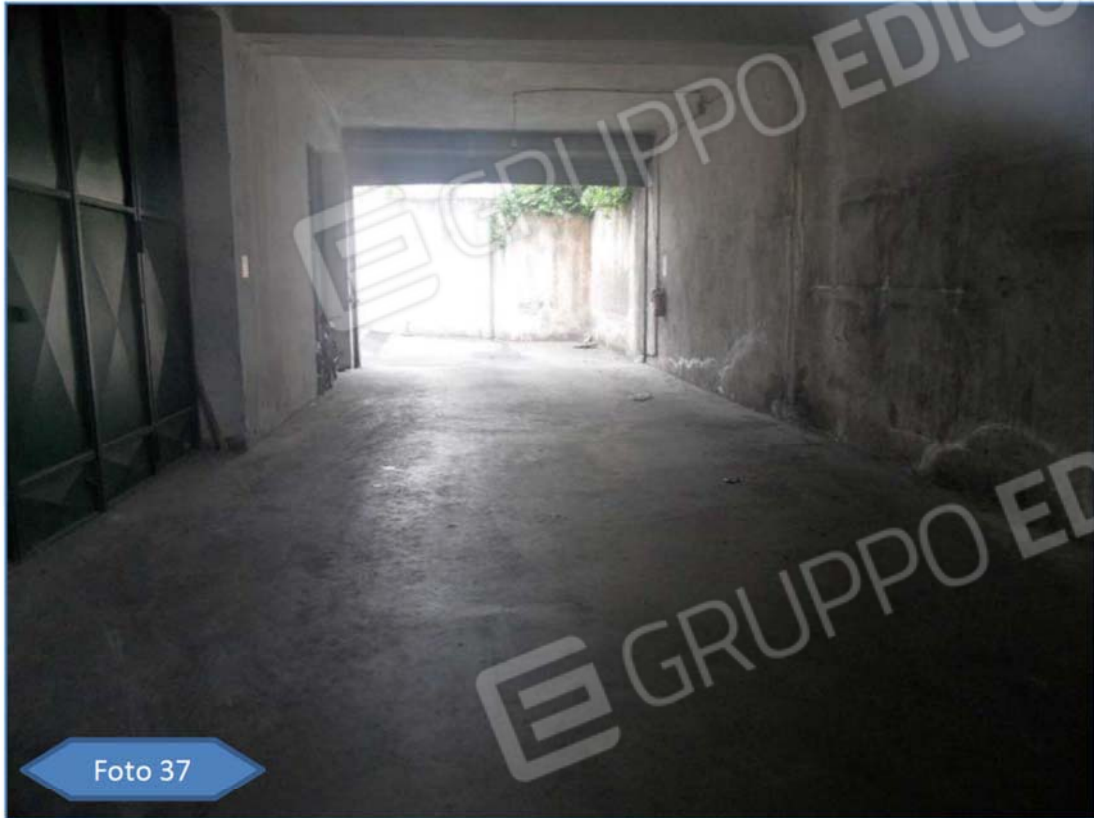
Parte Comune – Accesso ai box del piano seminterrato.
