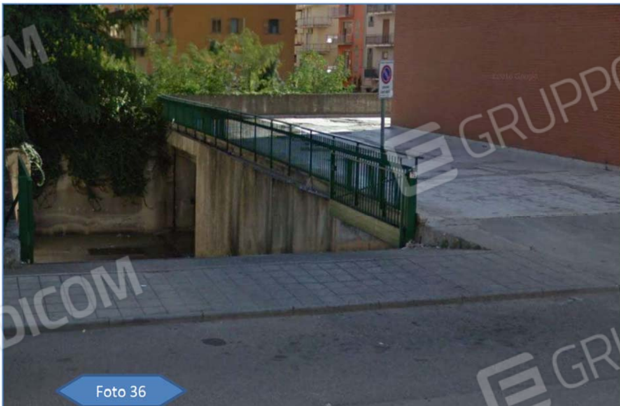
Lotto 2 – Rampa di accesso al lotto 2, da via Gramsci, lato Nord.
