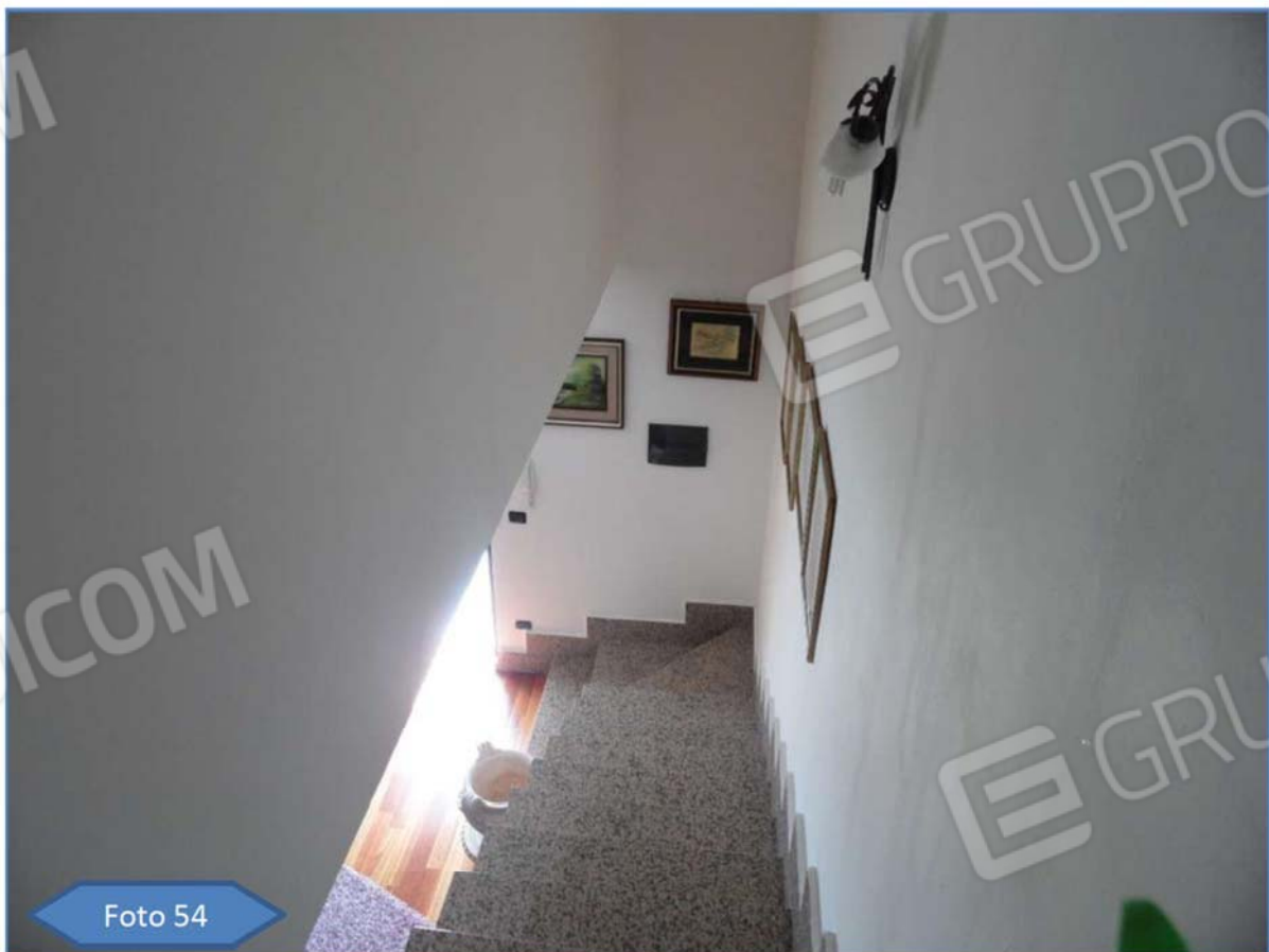
Lotto 3 – Scale accedenti al piano primo.
