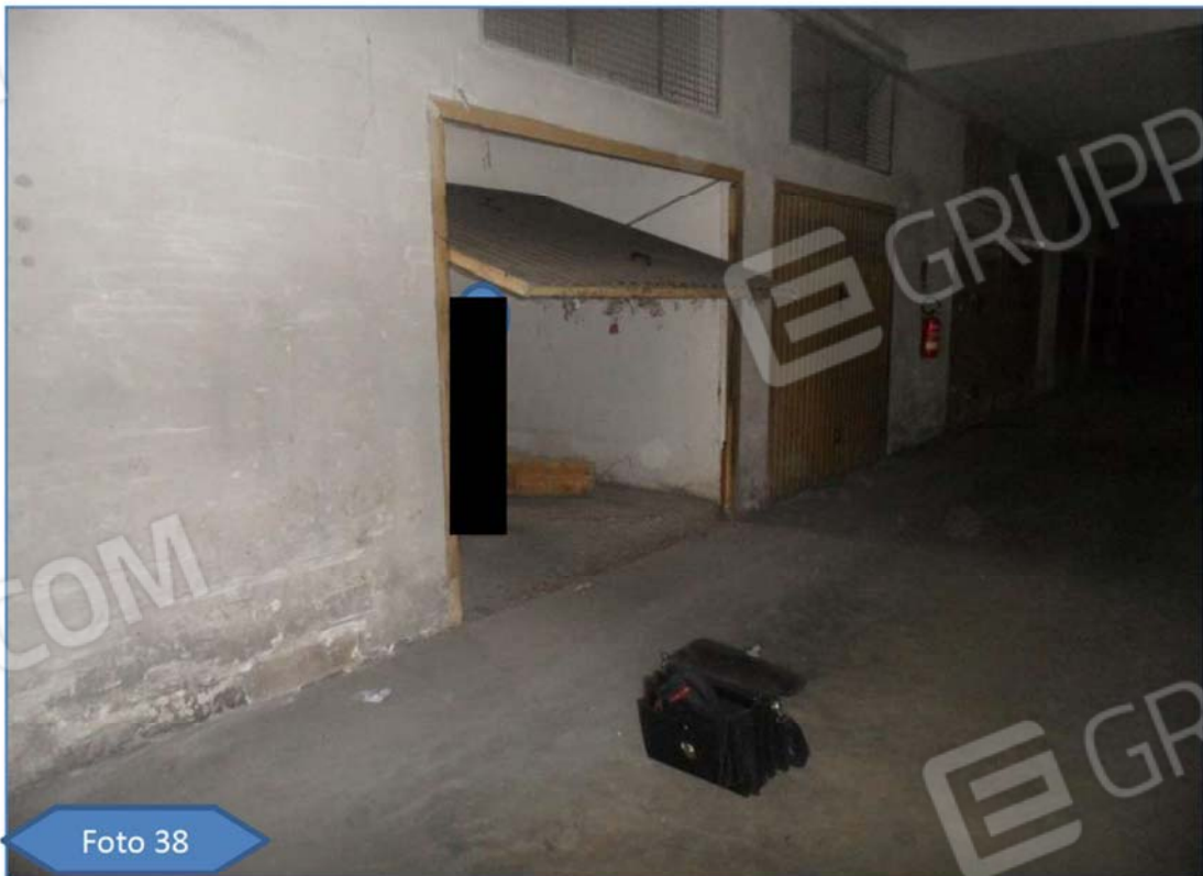
Lotto 2 – Vista dell'accesso al bene in questione.
