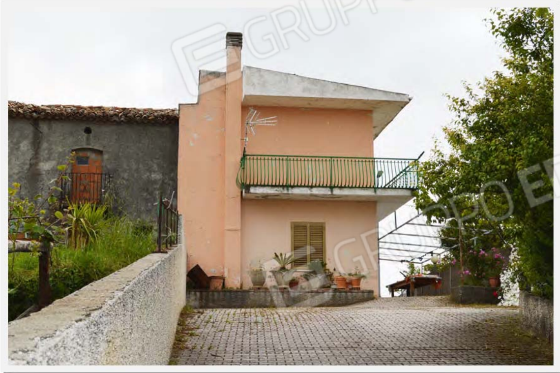
1 - Particella 463, vista del prospetto ovest
