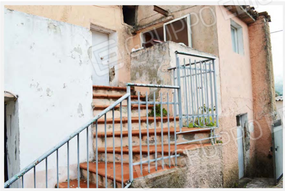
3 - Particolare della scala esterna
