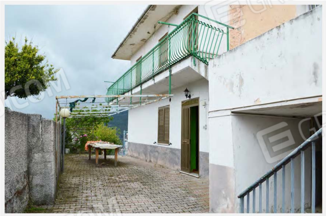
2 - Vista del lato sud
