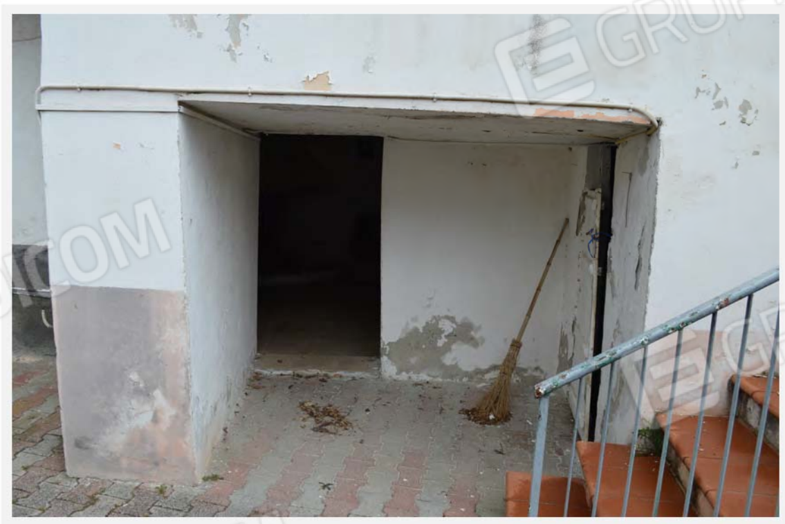
8 - Particella 574, vista ingresso locali al piano terra
