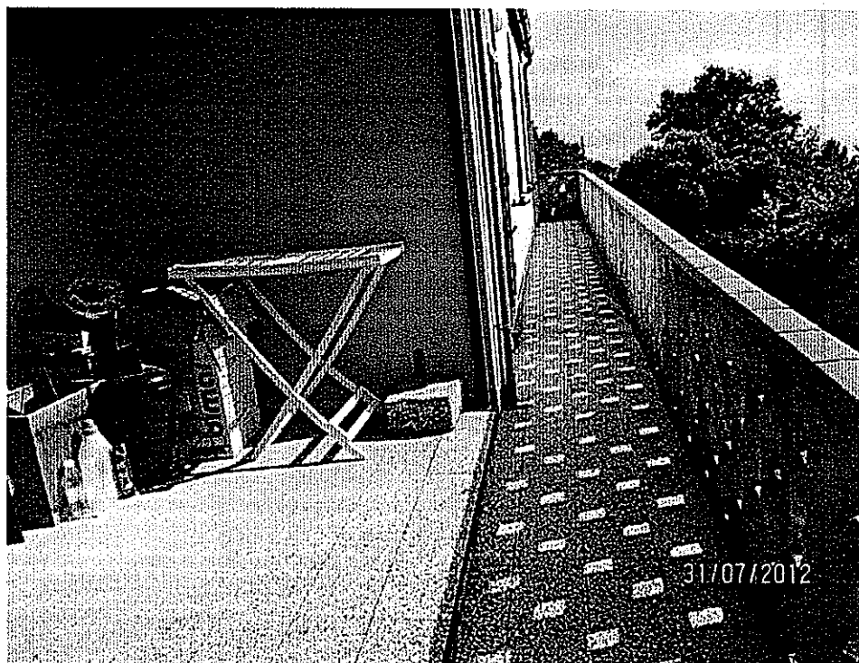
Foto n. 18 – Terrazzo che collega i due appartamenti
