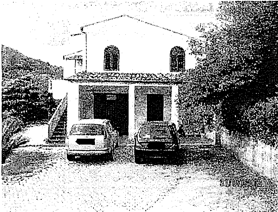
Foto n. 5 – Vista dei locali al piano terra con portico
