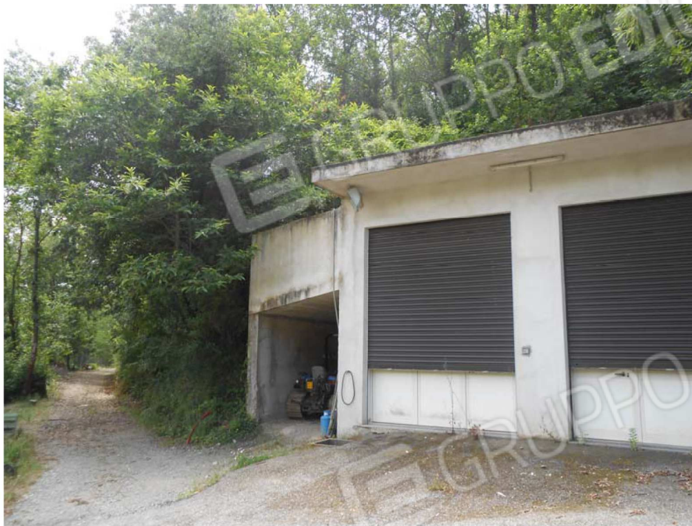
Foto n. 13: prospettiva fabbricato individuato dalla particella 534, foglio di mappa 34, del comune di Filadelfia.
