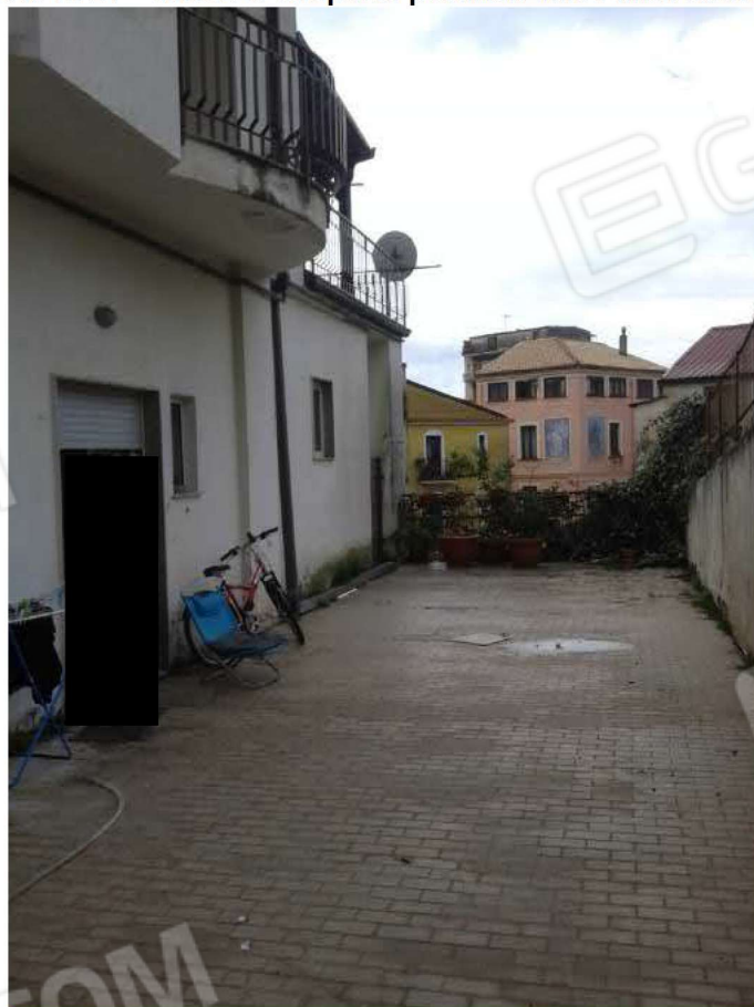
Foto n. 21 – terrazzo scoperto pertinenziale . unità sub.32.
