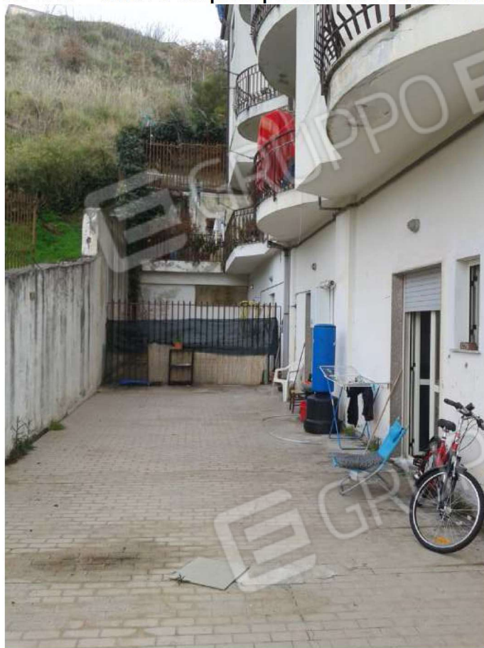
Foto n. 20 – terrazzo scoperto pertinenziale . unità sub.32.
