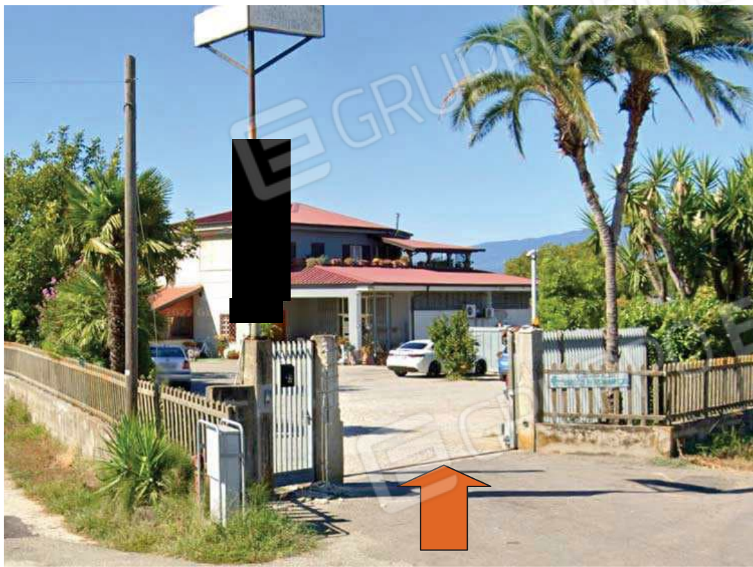
FOTO 1. Immobile tipologia cielo-terra.
