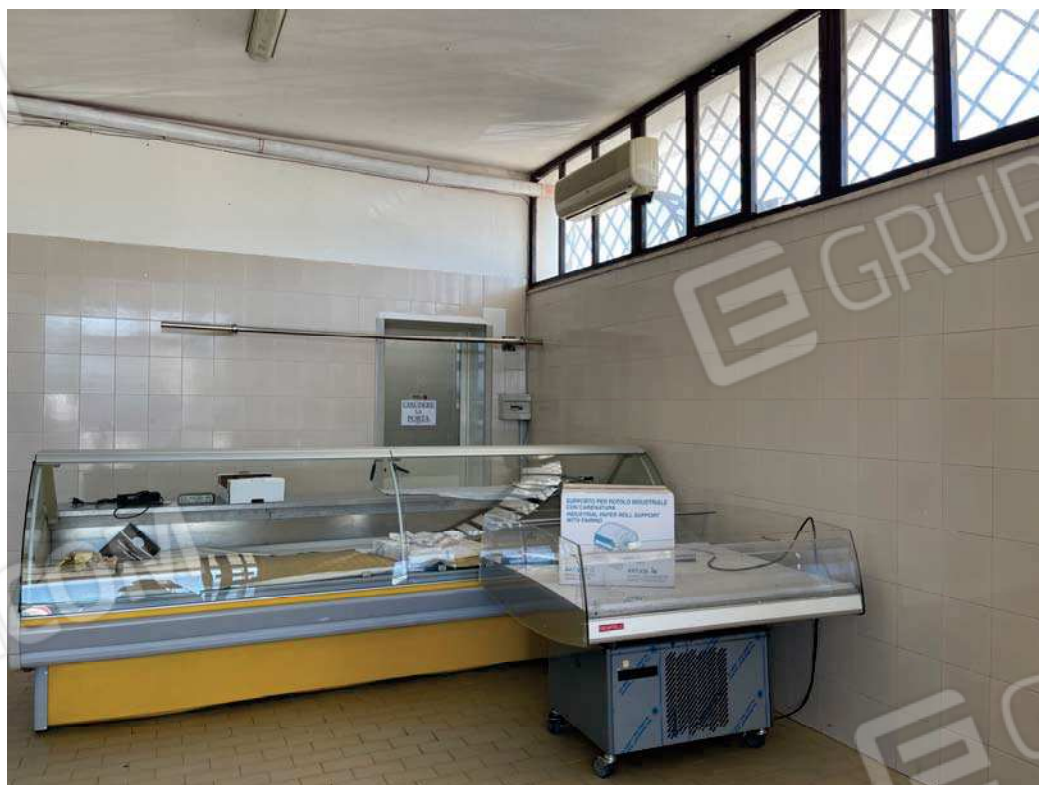
FOTO 6. Particolare – Finestre a nastro- area vendita.
