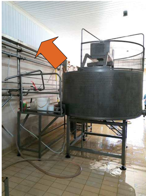
FOTO 12. Pannellatura a chiusura delle finestre.
