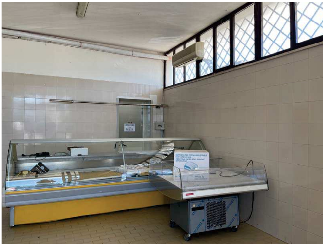
FOTO 6. Particolare – Finestre a nastro- area vendita.
