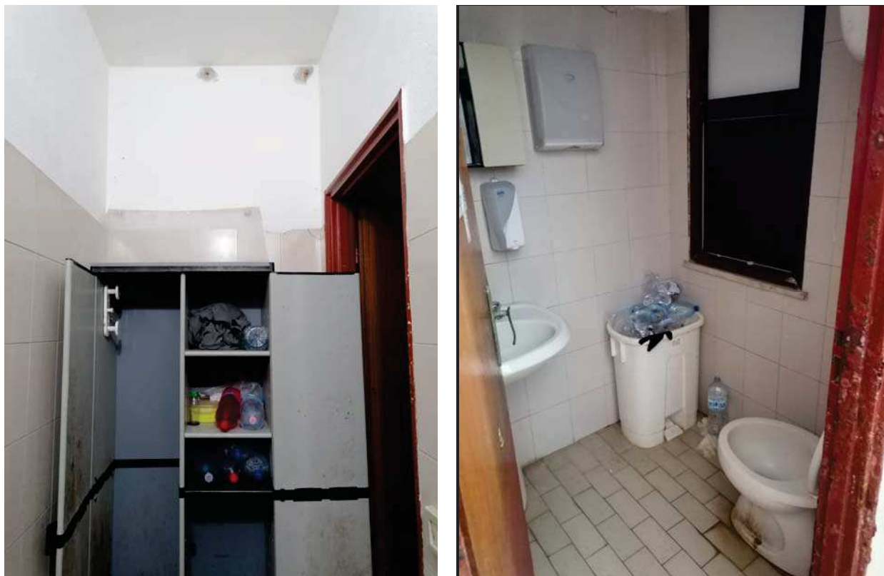
FOTO 15-16. Particolari dello Spogliatoio 3
