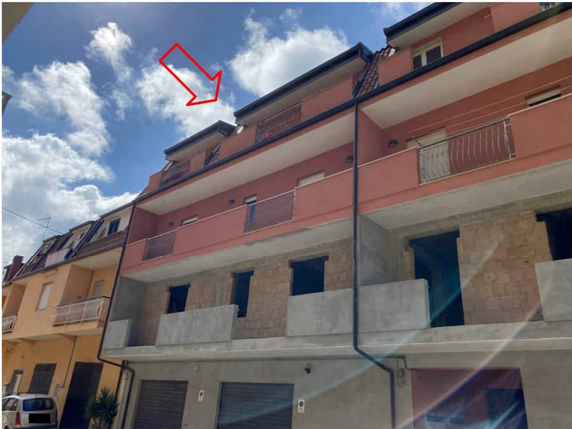
Foto prospetto Lotto Unico da Via A. Miceli n.24
