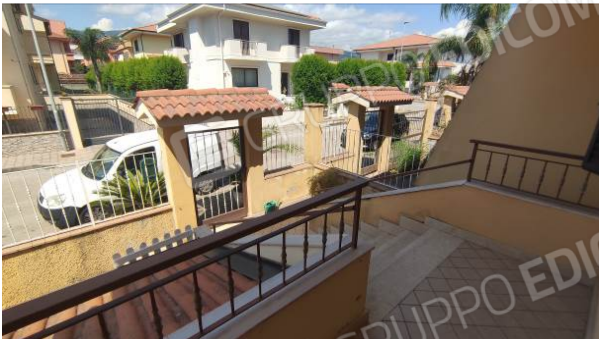
Foto n° 1: Via dei Sanniti, n°25 – accesso pedonale
