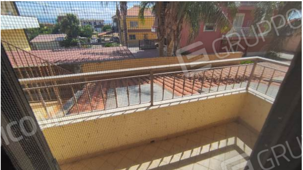
Foto n° 17: Piano terra rialzato – balcone soggiorno / sala da pranzo
