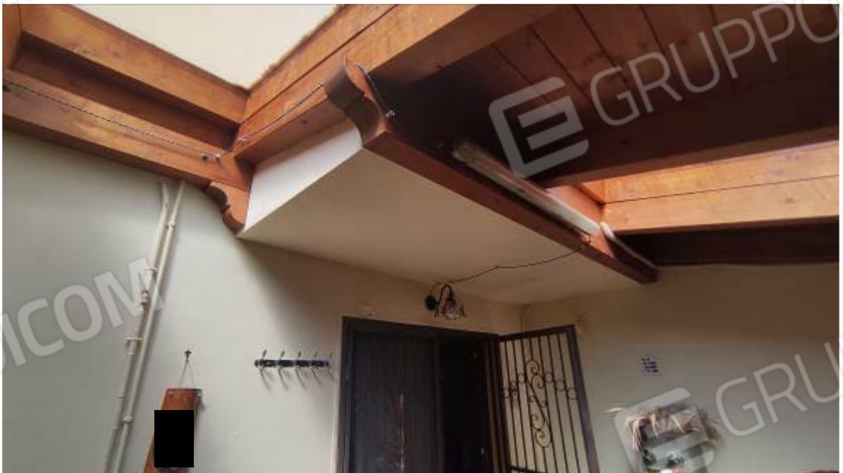
Foto n° 73: Piano Seminterrato – area non residenziale chiusa da tettoia
