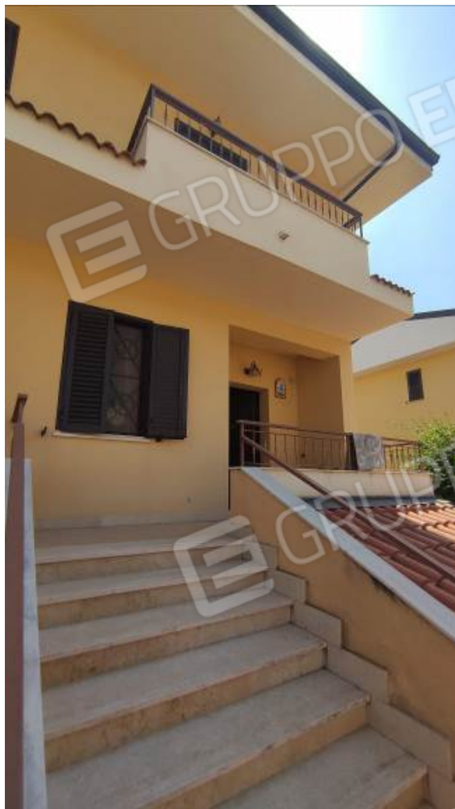
Foto n° 3: Ingresso principale unità immobiliare
