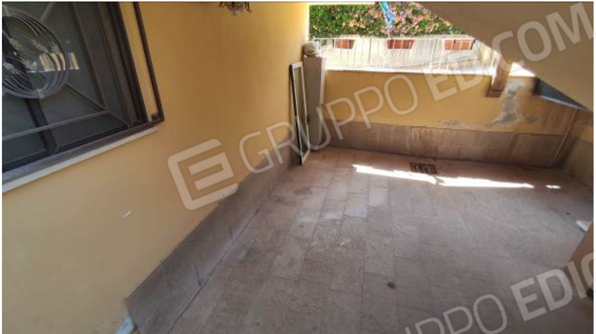
Foto n° 80: Corte di pertinenza
