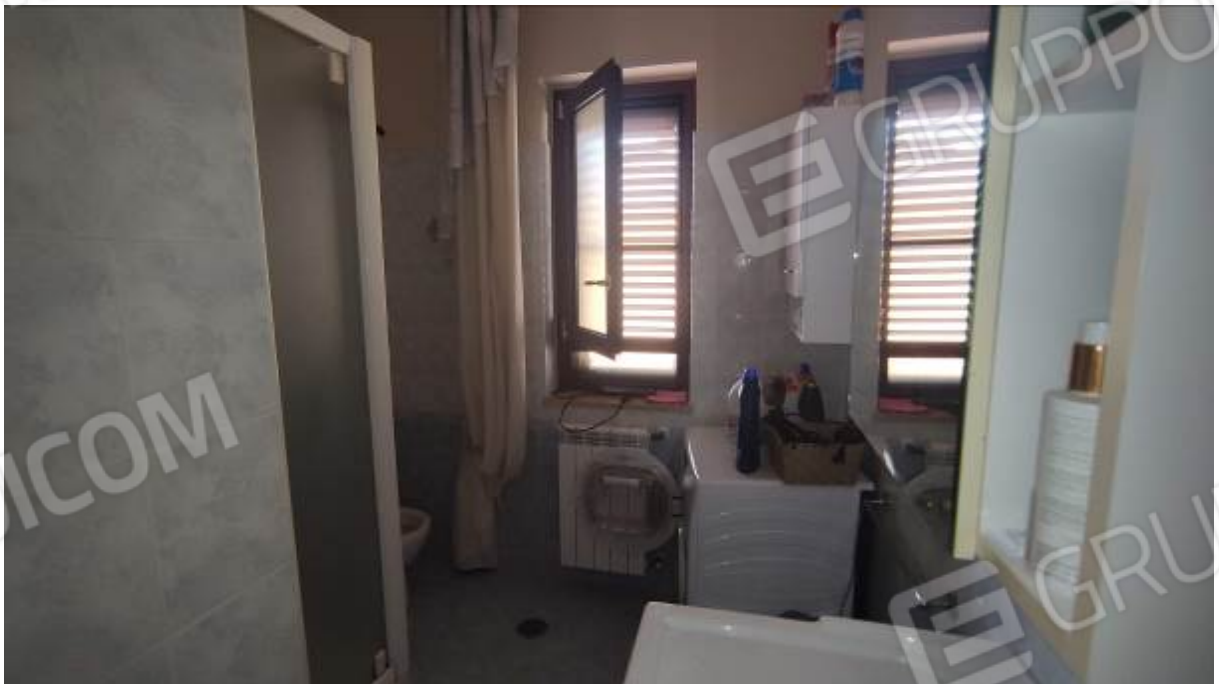
Foto n° 42: Piano Primo – servizio igienico secondario
