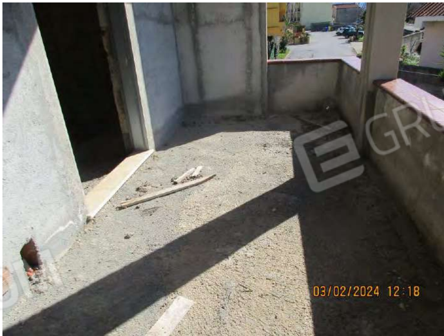
Foto n. 76 – Piano primo - Terrazzo ovest
