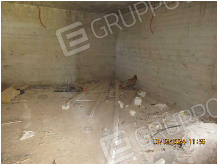
Foto. n. 65 – Piano Terra - Vano n.1
