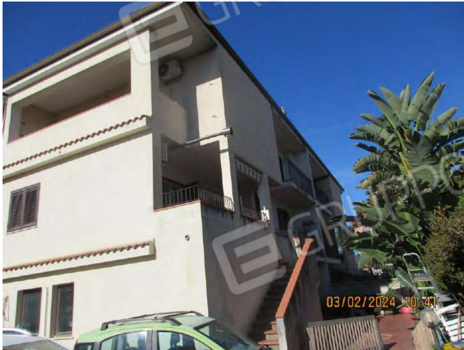
Foto. n. 1 – Prospetti sud ed est
