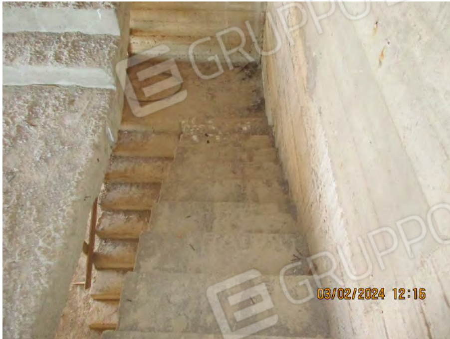
Foto n. 83 – Scala di accesso dal piano primo al piano secondo
