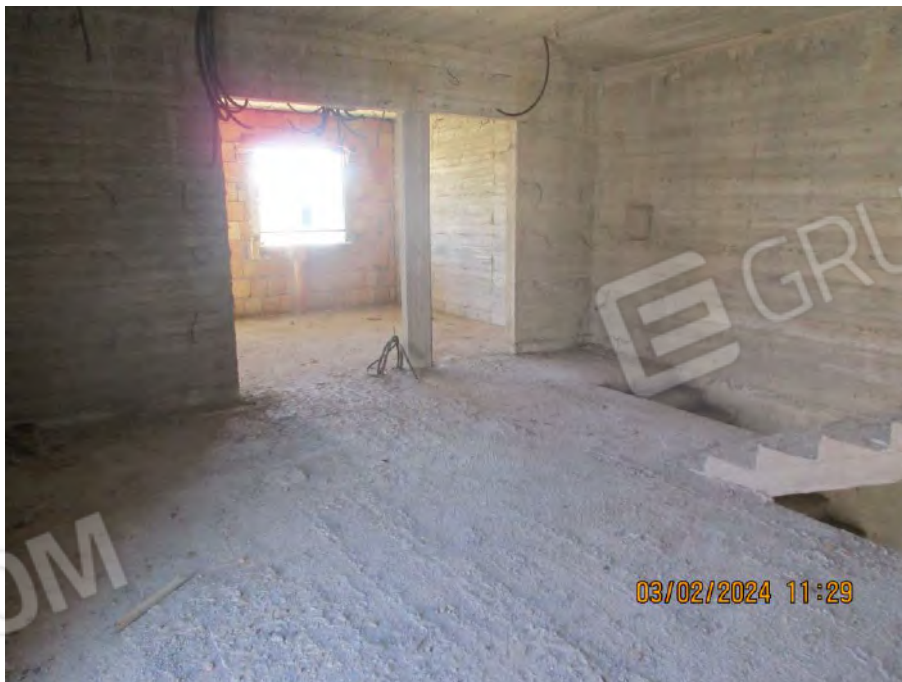
Foto n. 56 – Piano secondo - Vano n.1
