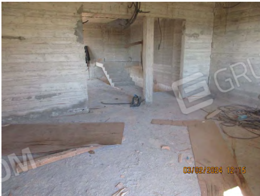
Foto n. 80 – Piano secondo - Vano n.2
