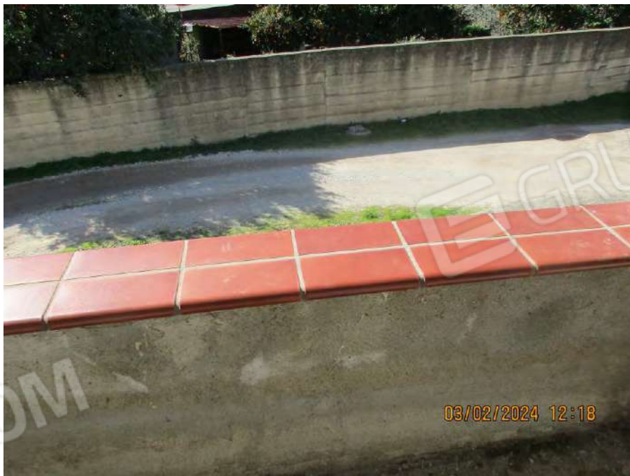
Foto n. 74 – Piano primo - Rivestimento muro terrazzo ovest
