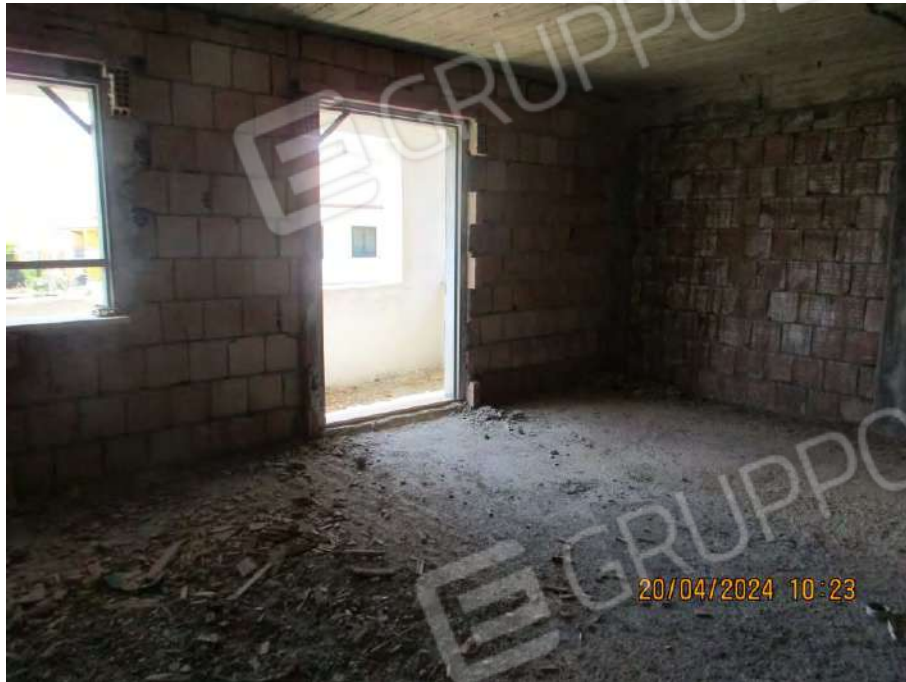
Foto n. 43 – Piano secondo - Vano n.2
