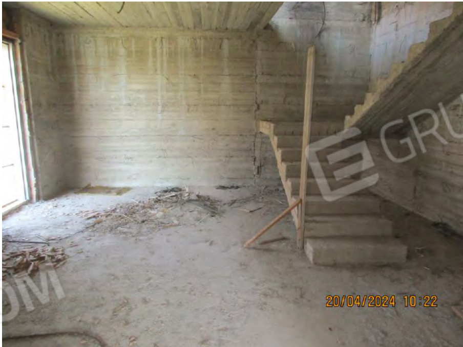
Foto n. 38 – Piano primo - Vano n.1
