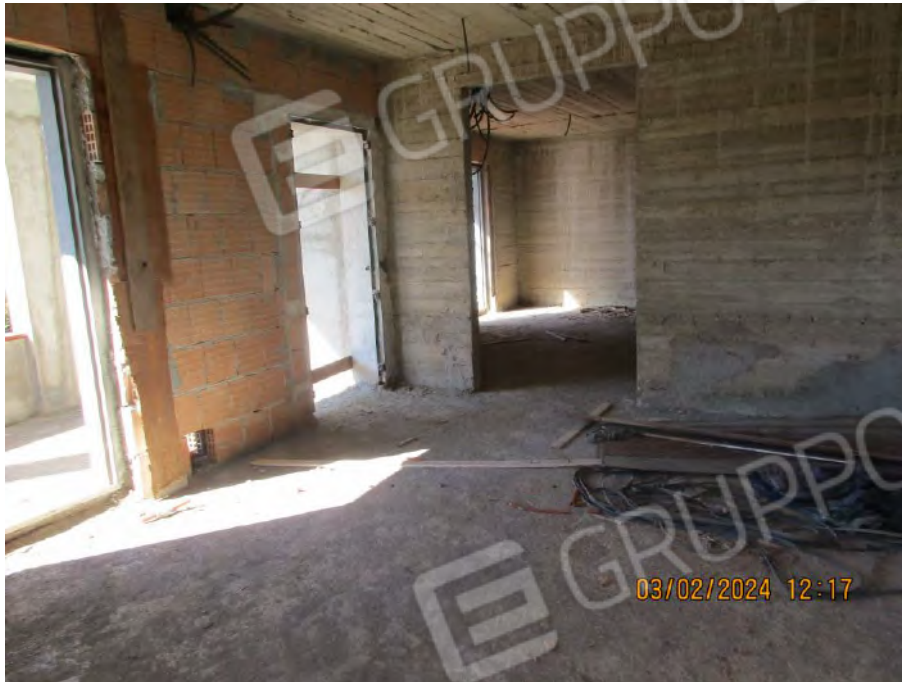
Foto n. 73 – Piano primo - Vano n.2
