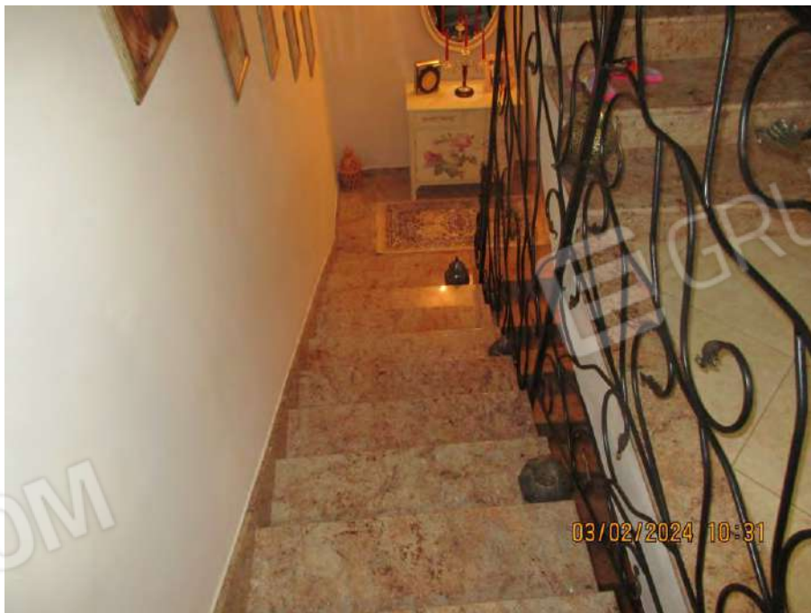
Foto n. 14 – Scala di accesso al piano secondo
