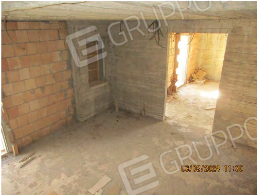
Foto n. 9 – Piano primo - Vano n. 1
