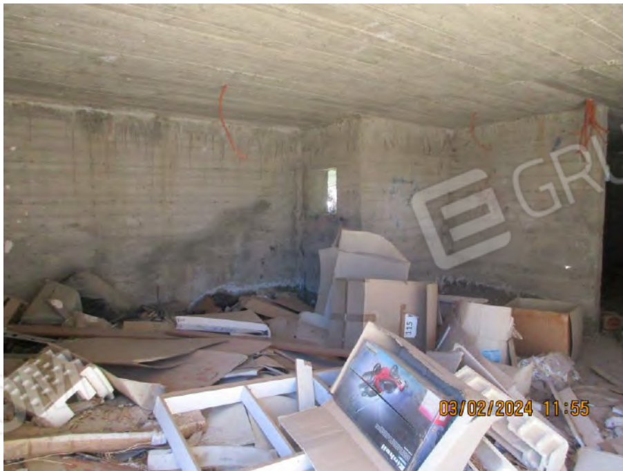
Foto. n. 66 – Piano Terra - Vano n.2
