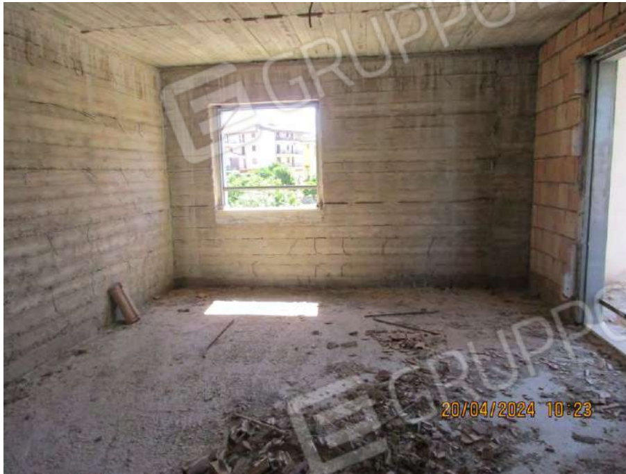
Foto n. 39 – Piano primo - Vano n.2
