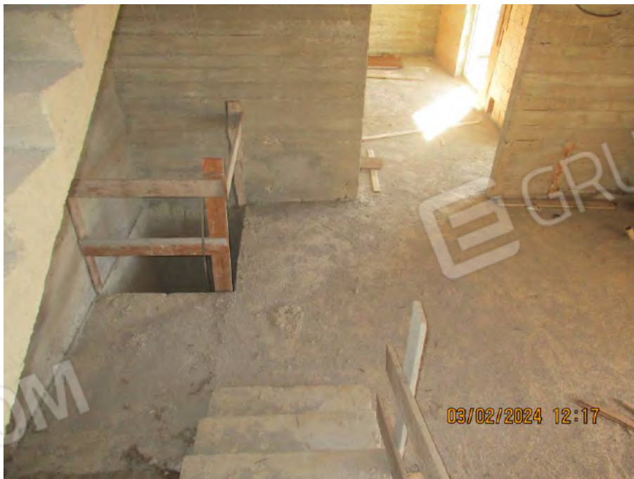
Foto n. 70 – Piano primo - Vano n. 1
