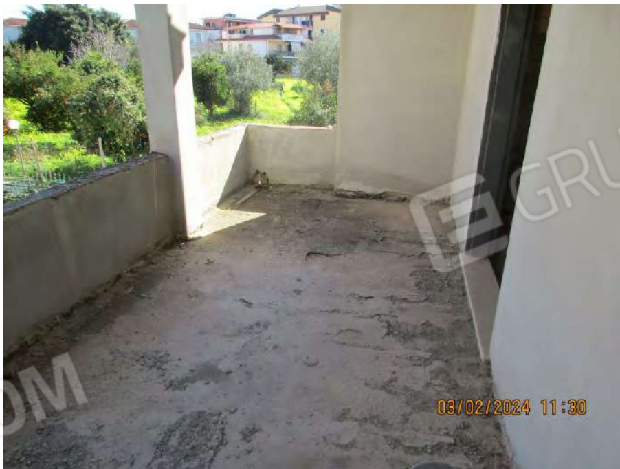
Foto n. 54 – Piano primo - Terrazzo est
