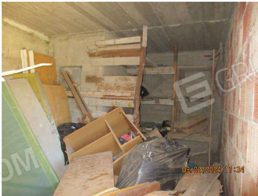
Foto. n. 36 – Piano terra - Vano n.3
