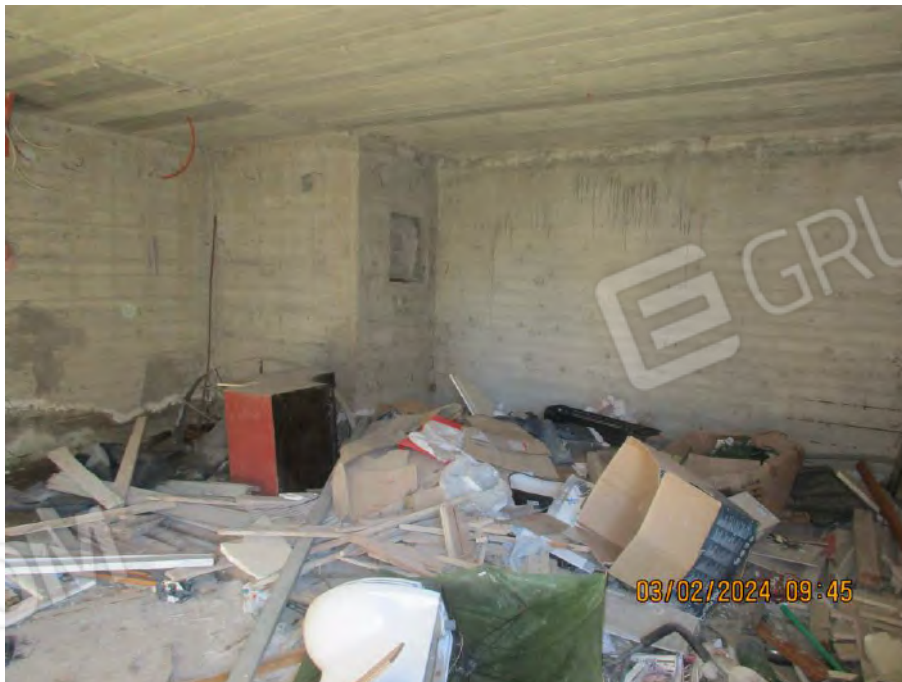
Foto. n. 50 – Piano terra - Vano n.2
