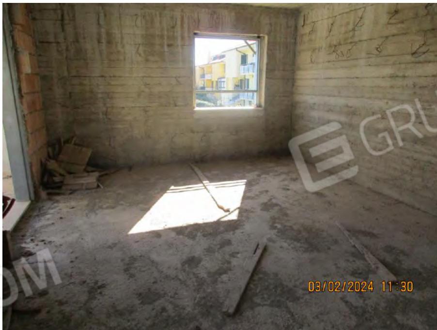
Foto n. 10 – Piano primo - Vano n.2
