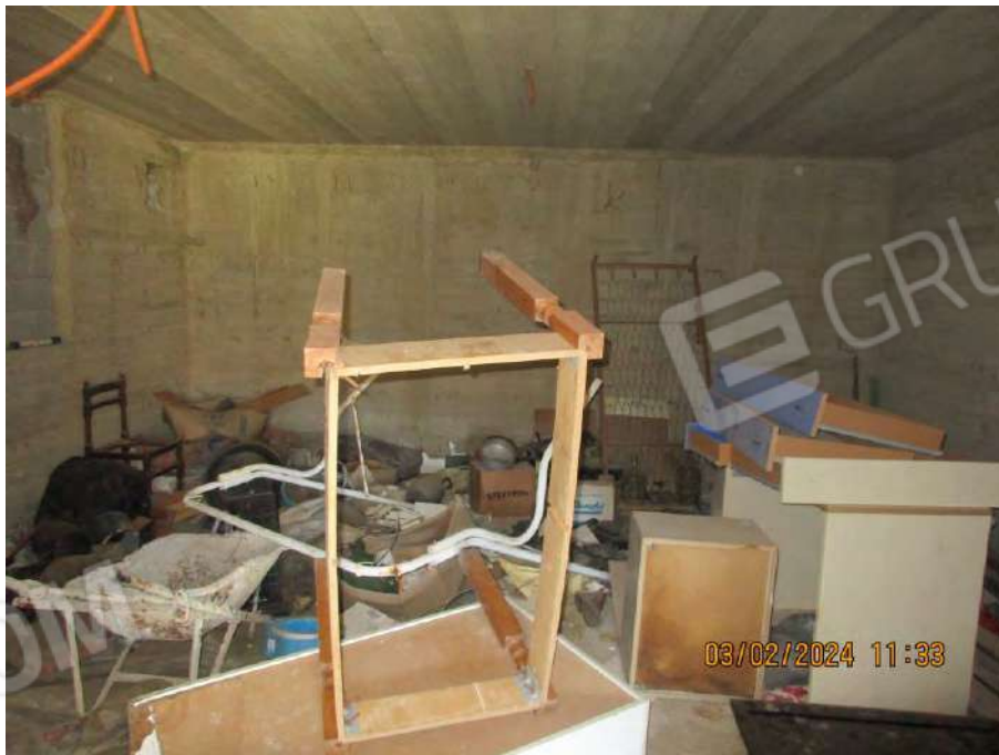
Foto. n. 32 – Piano terra - Vano n.1
