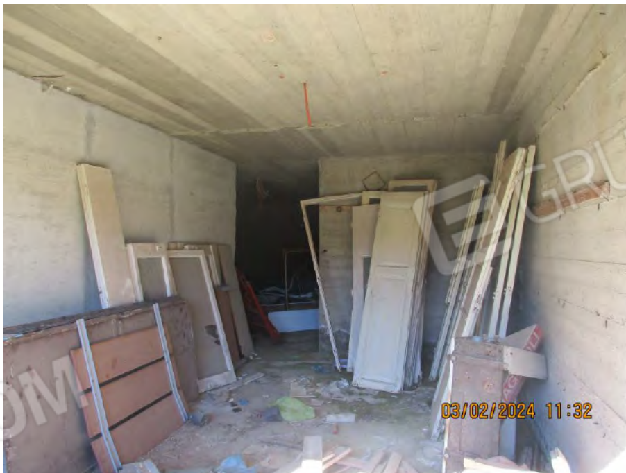
Foto. n. 34 – Piano terra - Vano n.2
