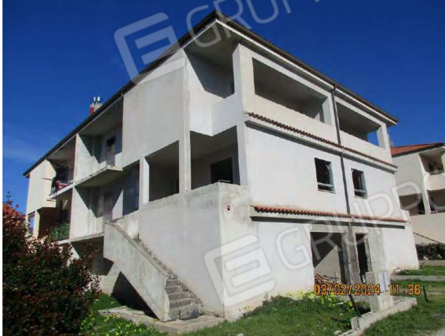
Foto. n. 29 – Prospetti sud ed ovest
