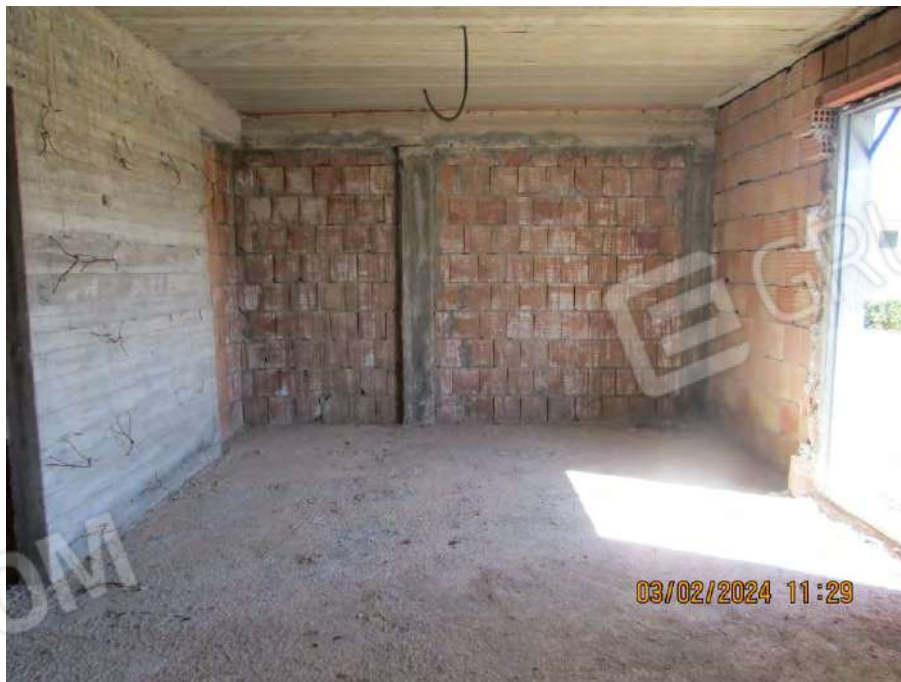
Foto n. 58 – Piano secondo - Vano n.2
