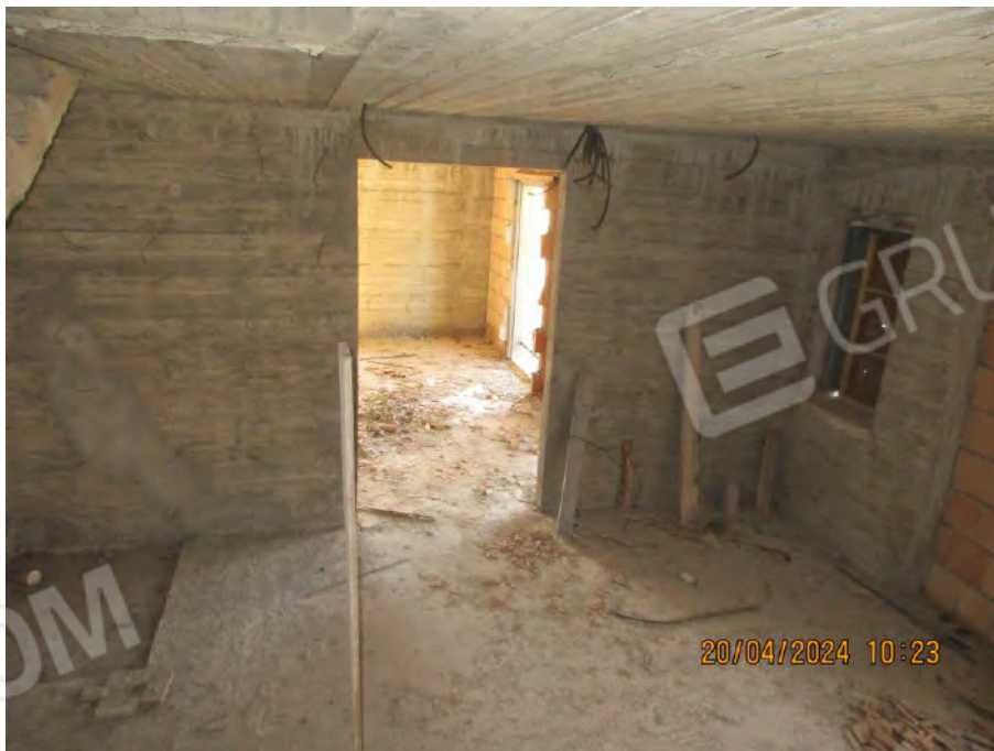
Foto n. 40 – Piano primo - Comunicazione tra vano 1 e 2
