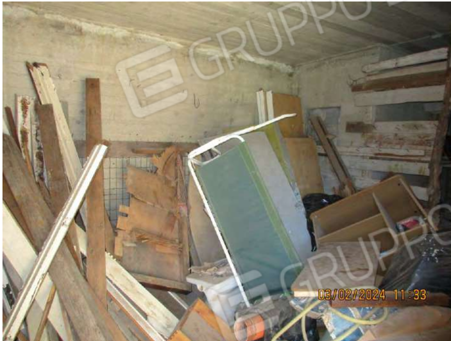
Foto. n. 35 – Piano terra - Vano n.3
