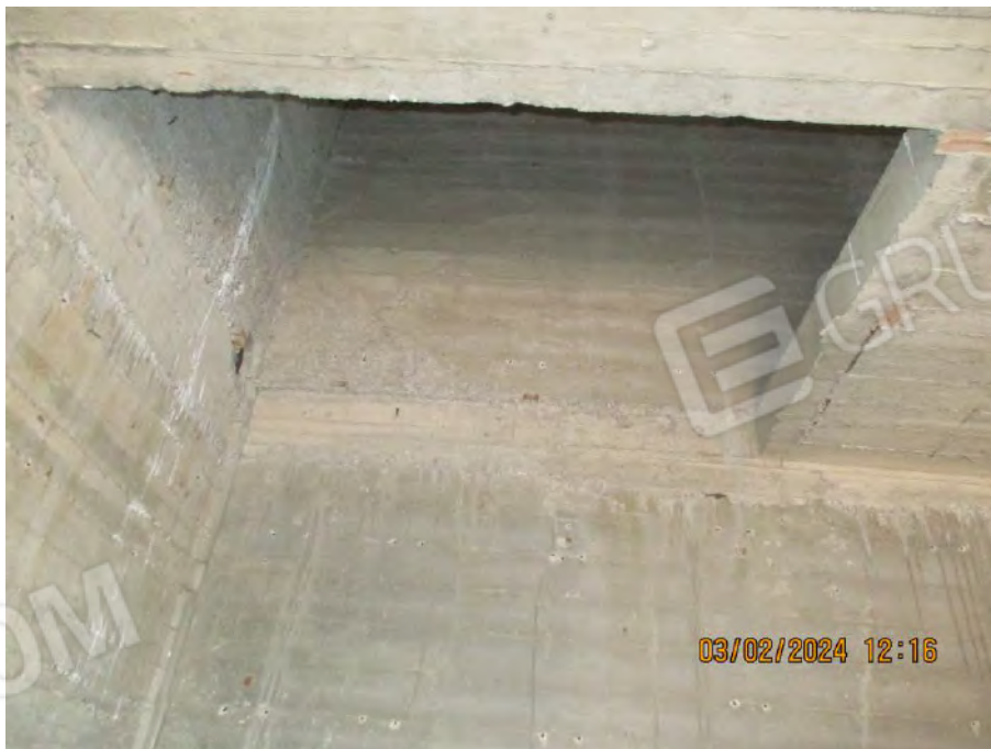
Foto n. 84 – Botola di accesso al piano sottotetto
