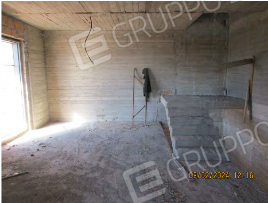
Foto n. 79 – Piano secondo - Vano n.1
