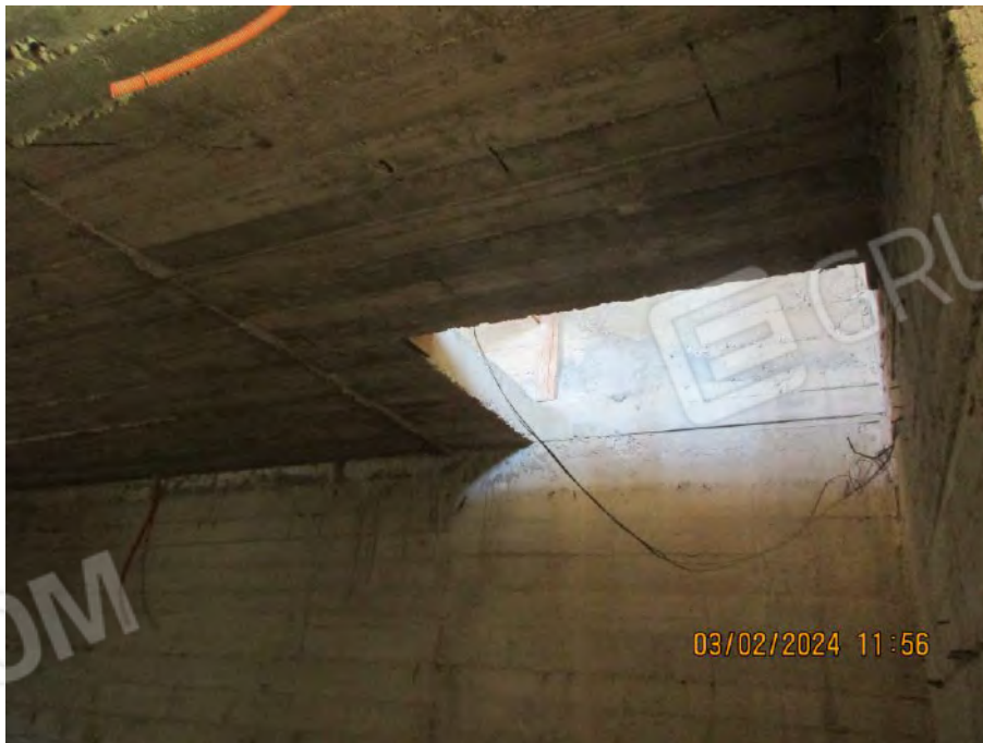
Foto. n. 68 – Piano Terra - Botola di accesso al piano primo
