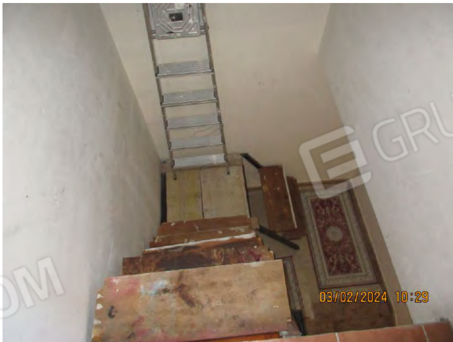
Foto n. 28 – Scala di accesso al sottotetto
