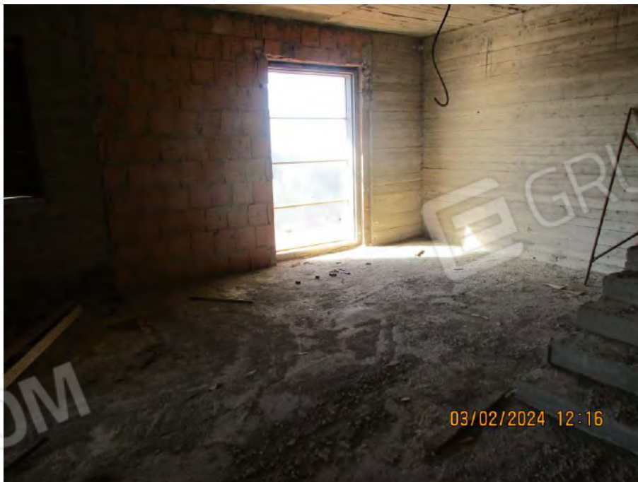
Foto n. 78 – Piano secondo - Vano n. 1
