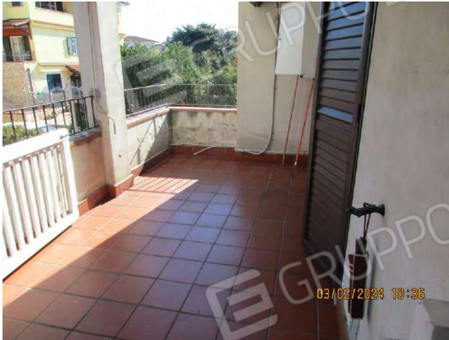
Foto n. 13 – Piano primo – Terrazzo
