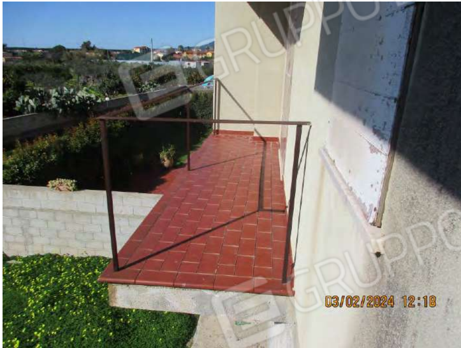
Foto n. 75 – Piano primo - Pavimento balcone ovest
