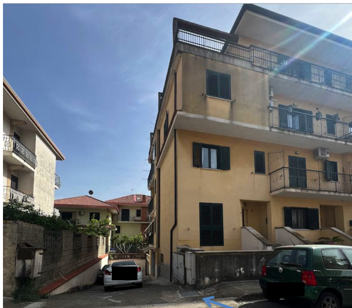
Figura 4 Accesso sub 2 Cat C/2
