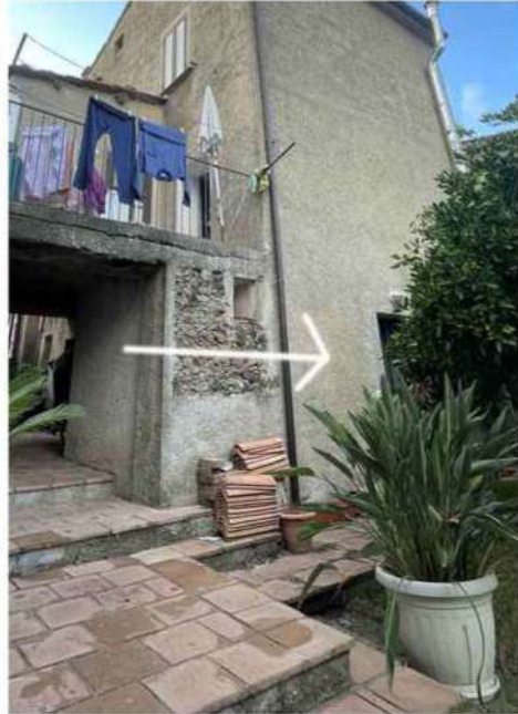
INGRESSO AMBIENTE N. 2
