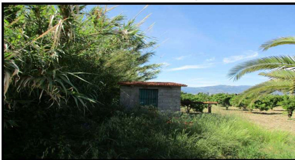
Foto. n. 12 – Fabbricato abusivo ospitante la stazione di sollevamento
