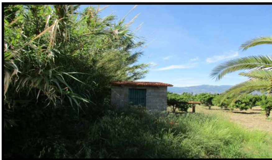
Foto. n. 1 – Stazione di sollevamento
