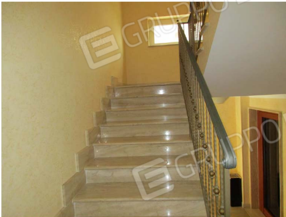
Foto n.°25 – Scala di accesso
