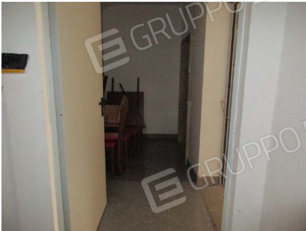
Foto n.°11 – Piano Seminterrato - Disimpegno
