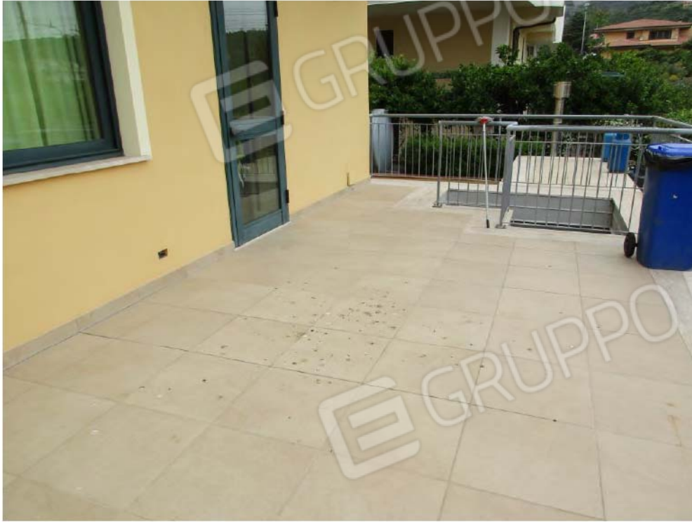
Foto n.°15 – Piano Terra –Terrazzo sud-est
