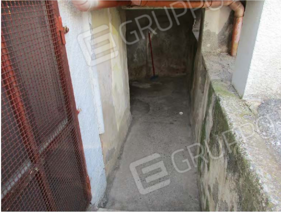
Foto n.°69 – Sub 4 – Accesso esterno
