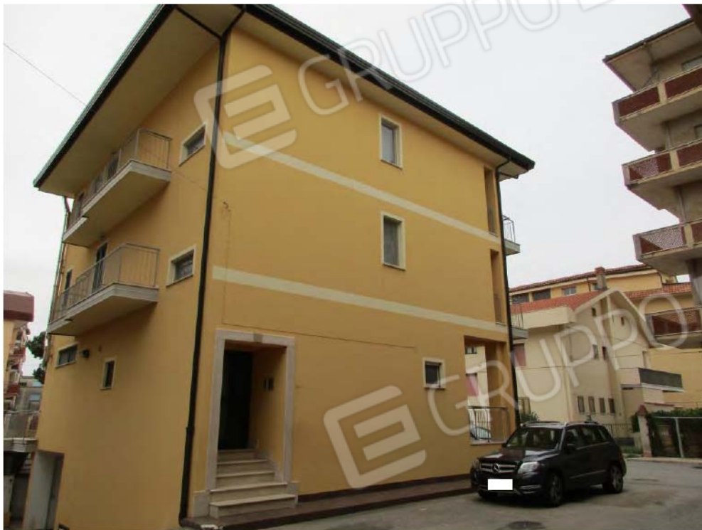
Foto n.°3 – Prospetto nord-ovest
