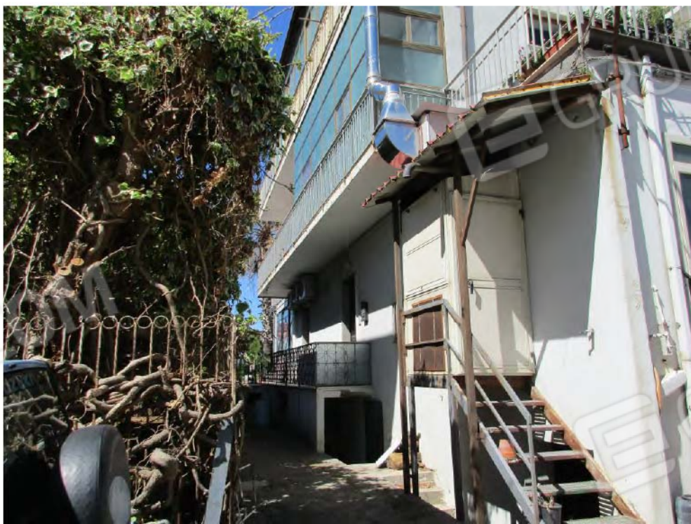
Foto n.°54 – Prospetto sud-est – Parte inferiore
