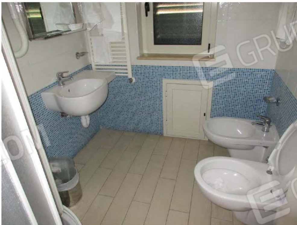
Foto n.°44 – Piano Secondo –Bagno n.°5
