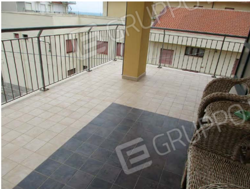
Foto n.°49 – Piano Secondo –Particolare terrazzo con affaccio a sud-est e sud ovest
