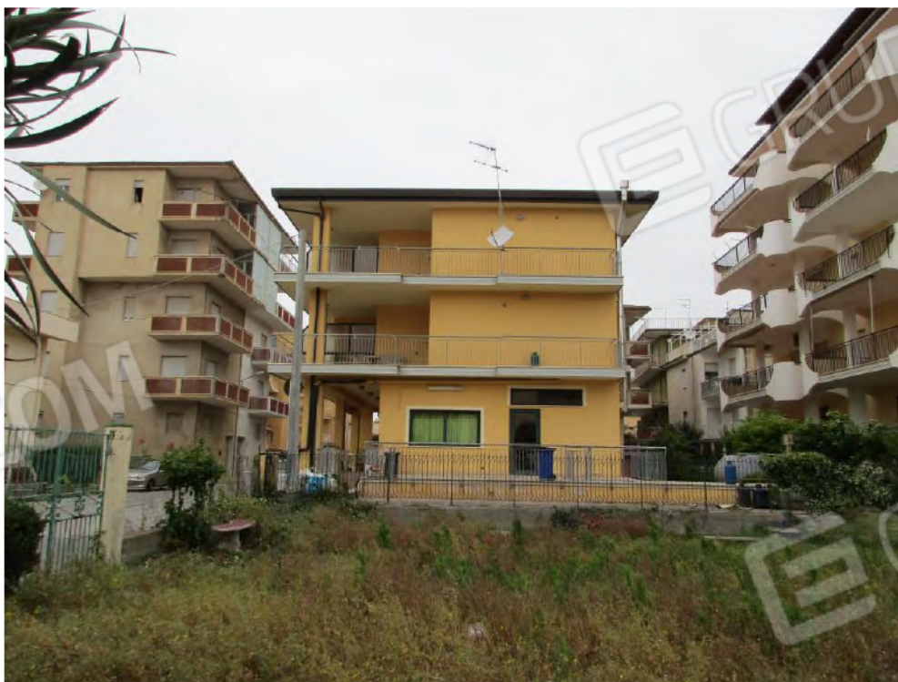
Foto n.°2 – Prospetto sud-est
