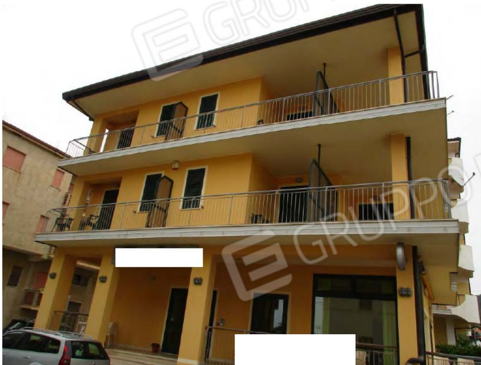
Foto n.°1 – Prospetto sud-ovest
