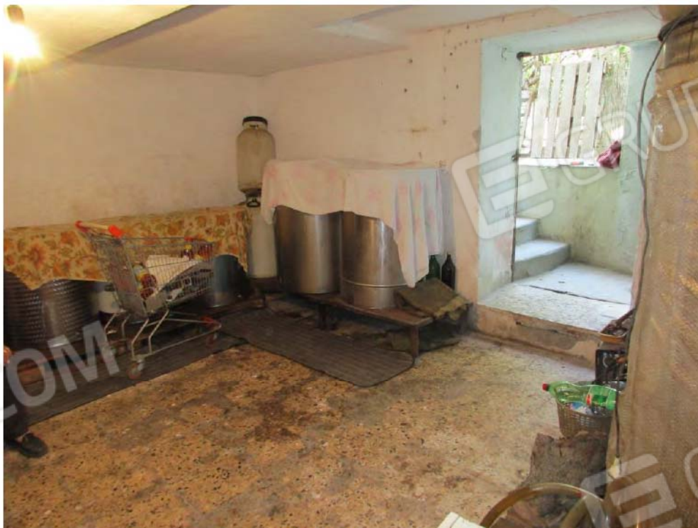
Foto n.°84 – Sub 3 – Deposito n.°1
