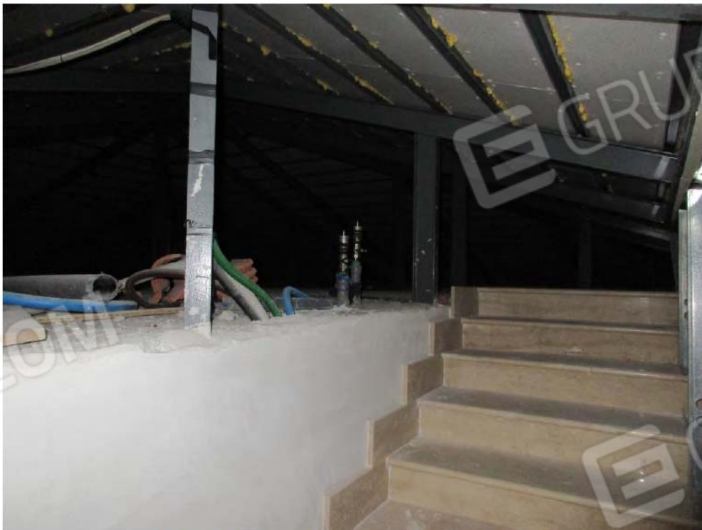
Foto n.°52 – Piano Secondo –Particolare sotto tetto
