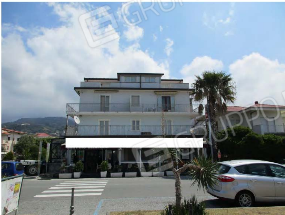
Foto n.°53 – Prospetto sud-ovest
