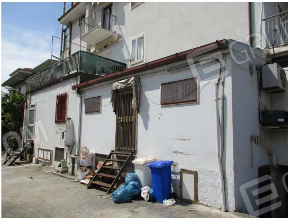
Foto n.°68 – Scala di accesso al laboratorio lato nord-est
