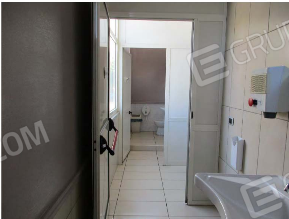
Foto n.°64 – Sub 1 – Disimpegno
