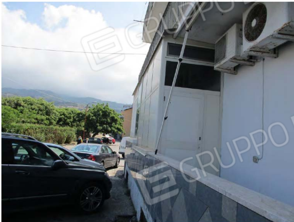
Foto n.°67 – Sub 1 – Bgno n.°3 – Accesso esterno
