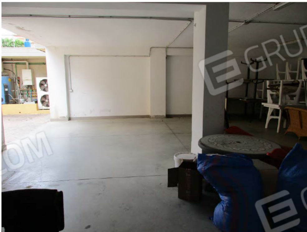
Foto n.°8 – Piano Seminterrato - Garage
