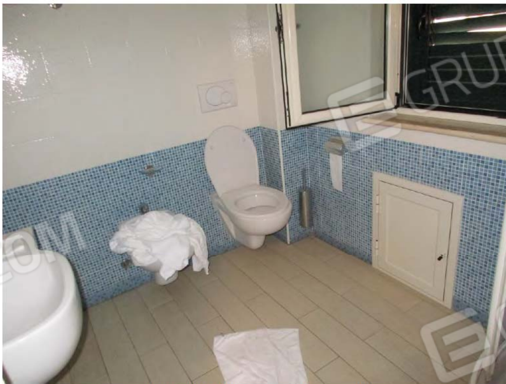
Foto n.º38 – Piano primo –Bagno n.º3
