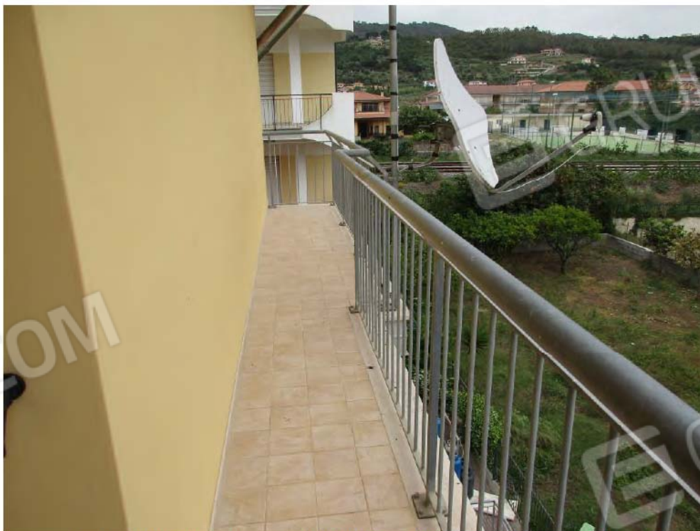
Foto n.°50 – Piano Secondo –Particolare balcone con affaccio a sud-est
