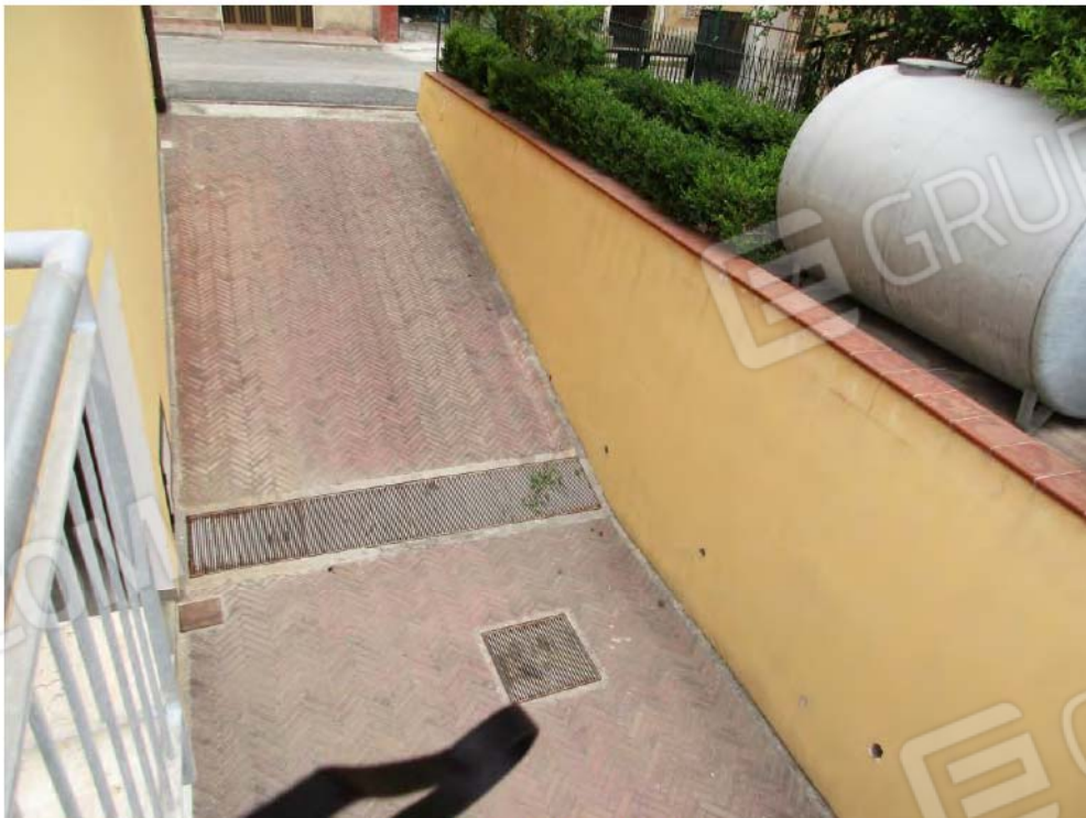
Foto n.°6 – Rampa di accesso
