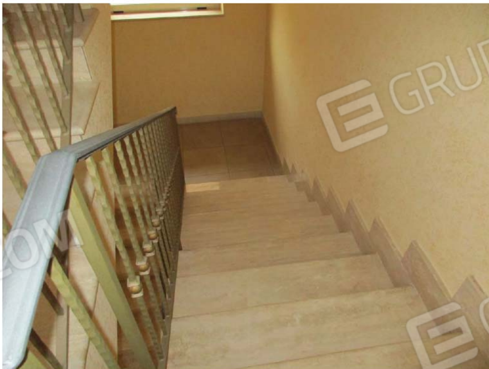
Foto n.°26 – Scala di accesso
