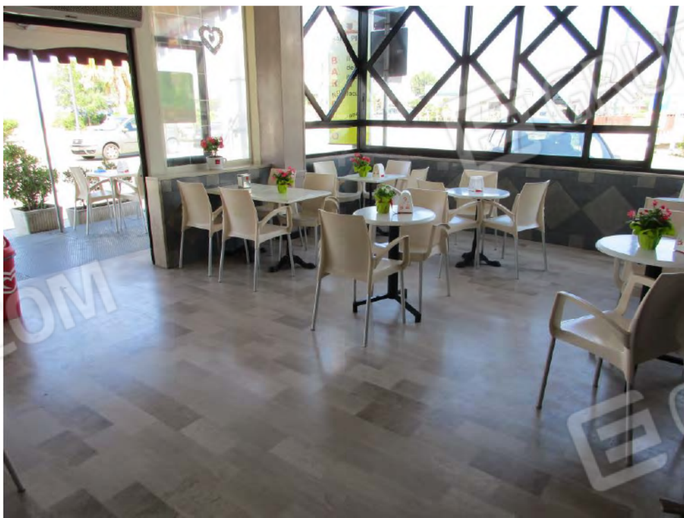
Foto n.º58 – Sub 1 - Veranda
