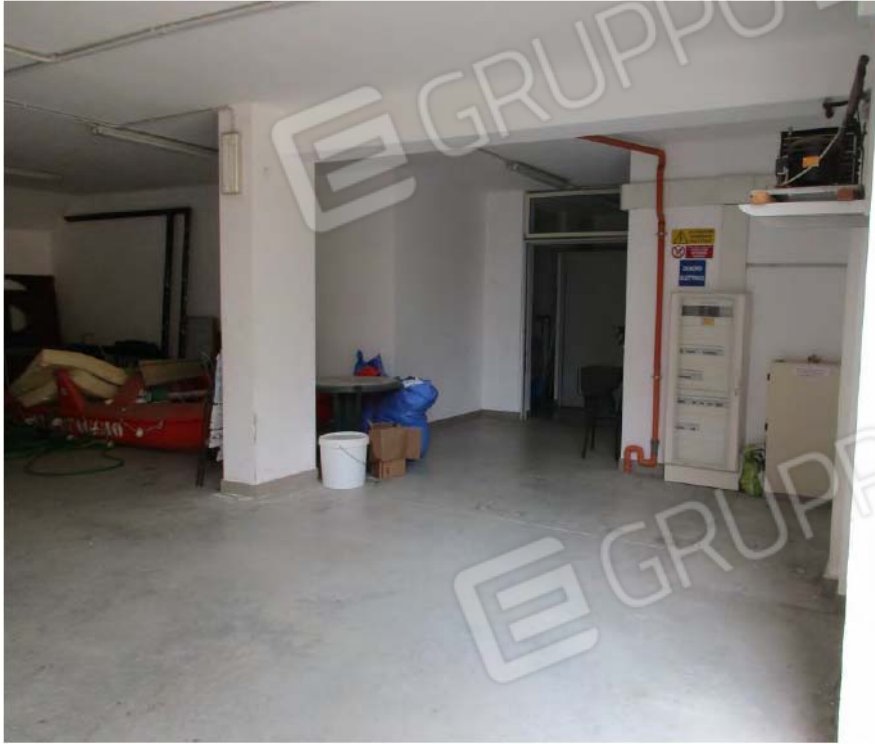
Foto n.º9 – Piano Seminterrato - Garage
