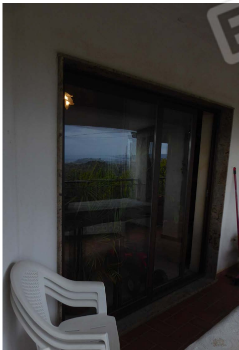
Foto Esterno 19. Fg 29 P.Ila 276 Sub 12
