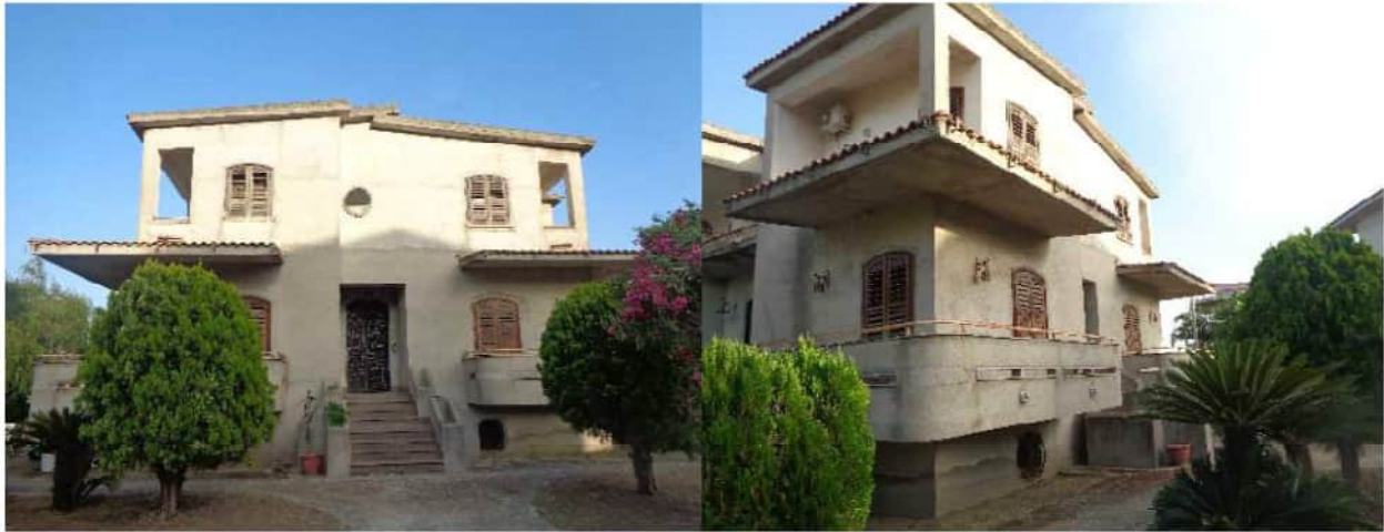
Fig.12 - Foto – Siderno. (RC) Vista esterna Immobile in Contrada Grappidaro foglio 16 part.lla 980
