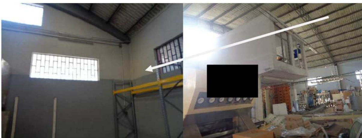
Fig. 8- Foto – Siderno (RC) Foto interne al Capannone
