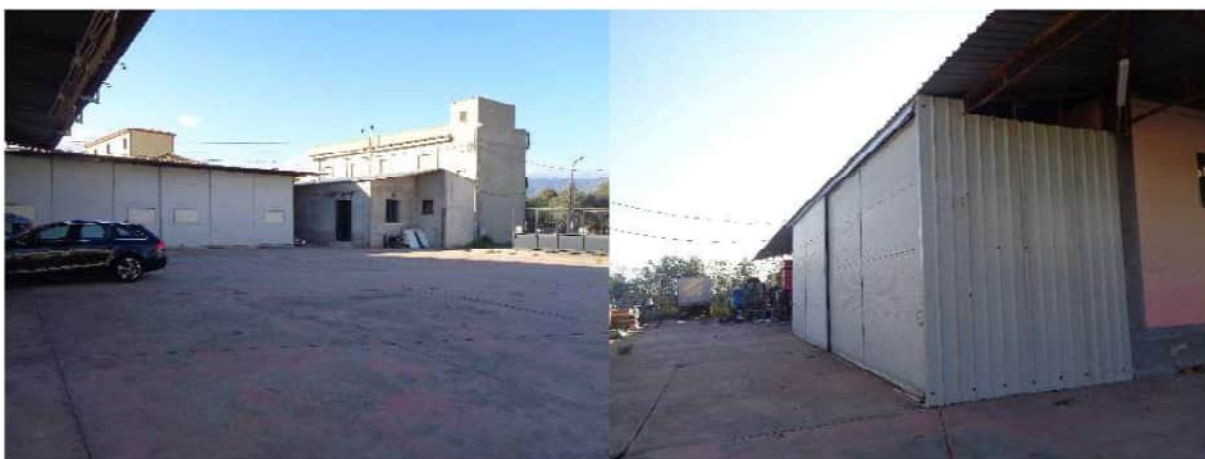
Fig. 9- Foto – Siderno- Vista Esterna Capannone
