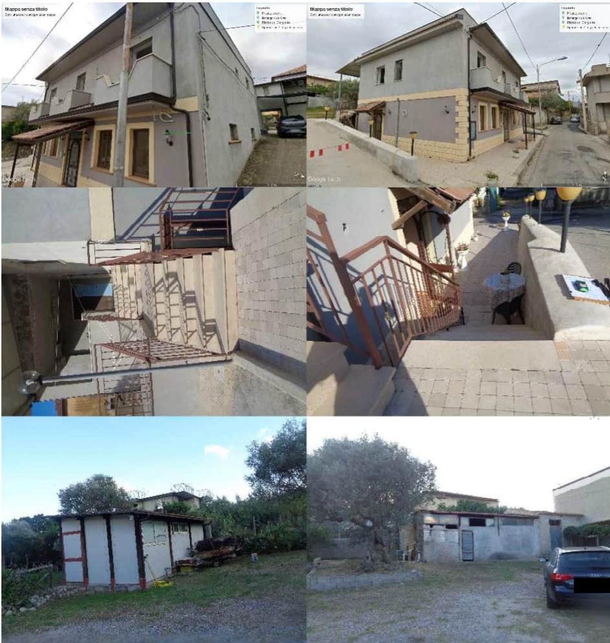
Fig.16 - Foto – Siderno. (RC) Vista esterna Immobili in Contrada Grappidaro foglio 16 part. 988-sub 5-6-7
