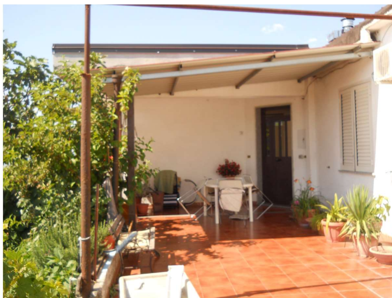
Foto n. 8 – Ingresso primo piano
