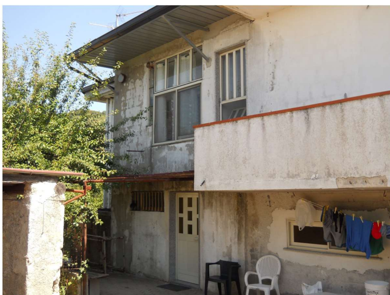
Foto n. 14 – Esterno laterale immobile
