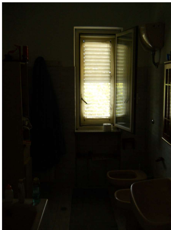
Foto n. 9 – Bagno piano terra
