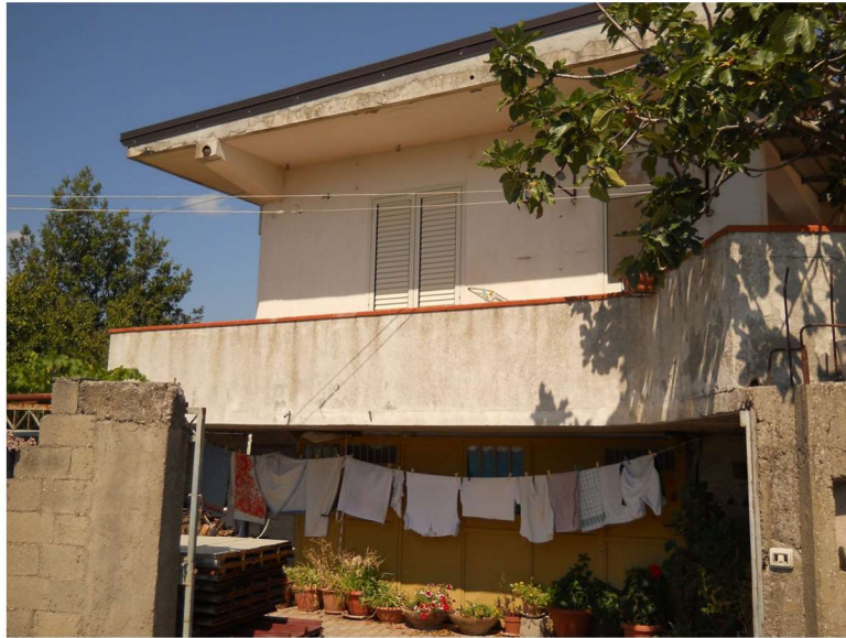
Foto n. 15 – Esterno della parte anteriore
