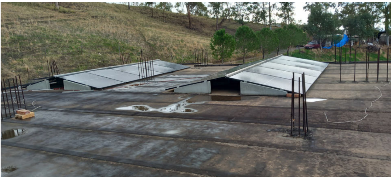
Figura 17: vista del lastrico solare, sub 4
