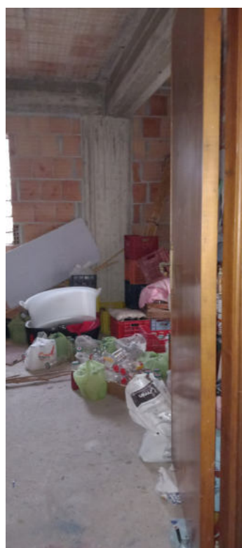
Figura 21: vista interna del ripostiglio al piano seminterrato (sub 3)
