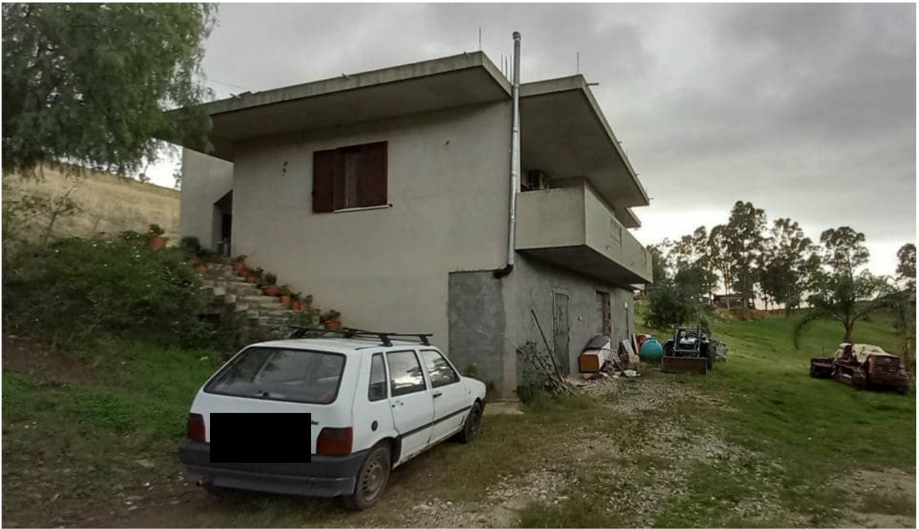
Figura 5: vista esterna del cespite lato nord - ovest
