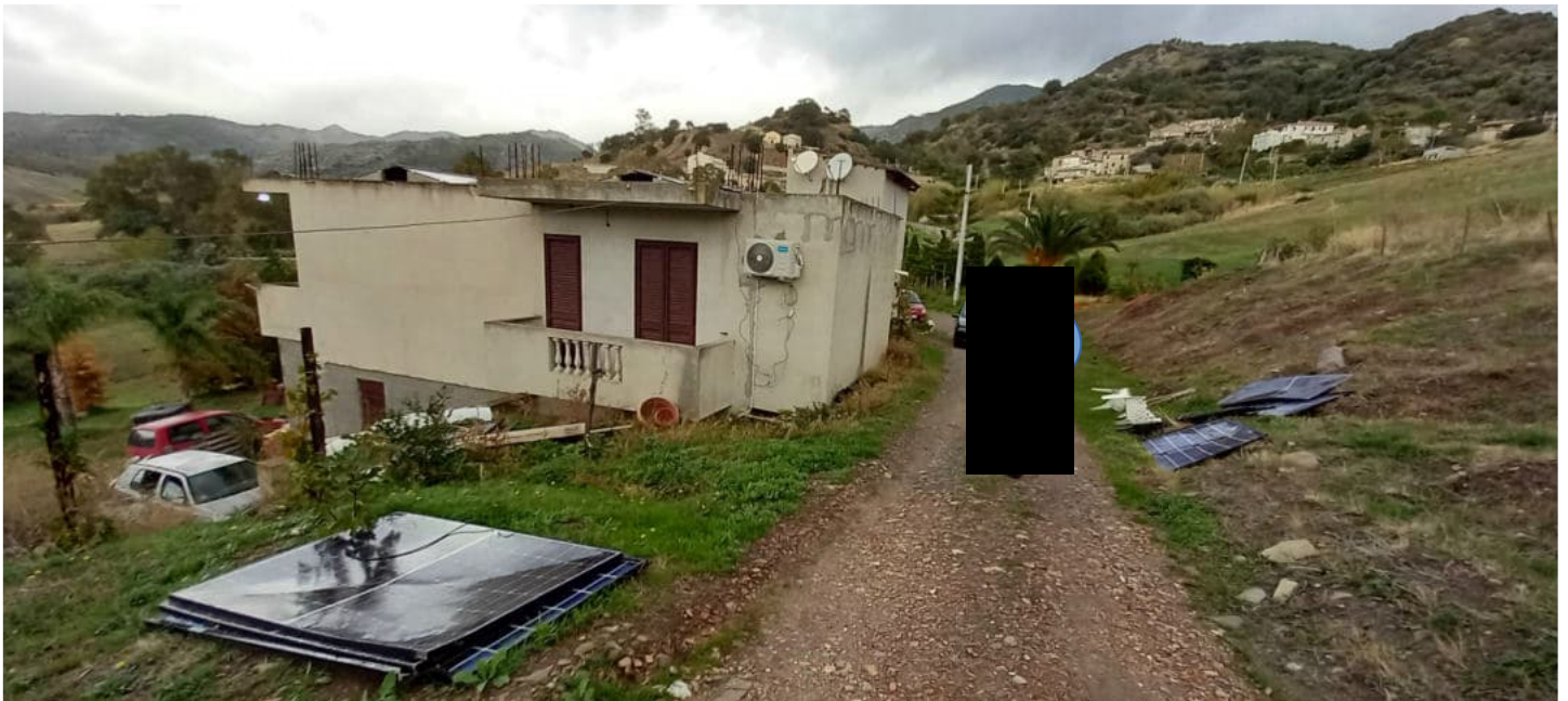
Figura 6: vista esterna del cespite lato sud - est
