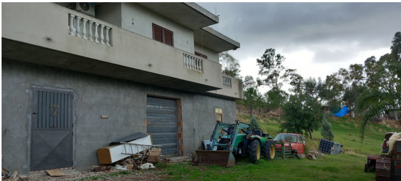
Figura 19: vista esterna del piano seminterrato (sub 3)
