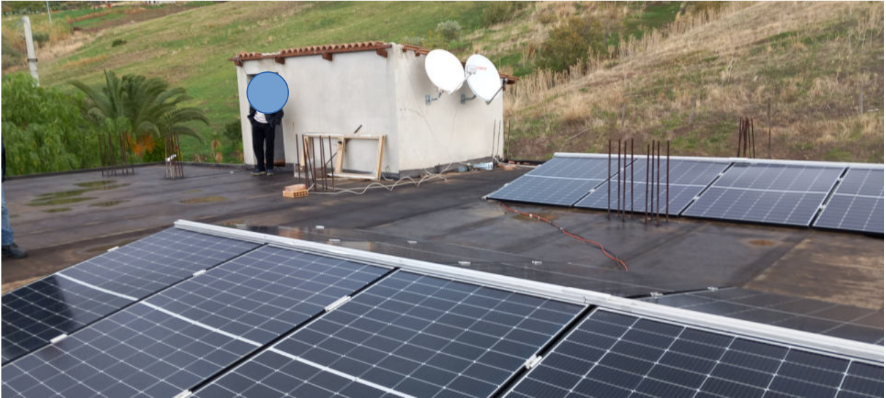
Figura 18: vista del piano primo, sub 4 (lastrico solare)
