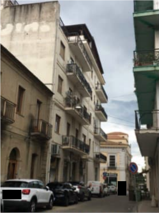
Foto N. 1 – Vista prospettica condominio da via .....
