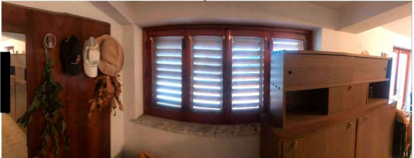
Finestratura nella zona di ingresso
