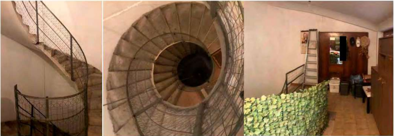
Scala priva di pavimentazione
