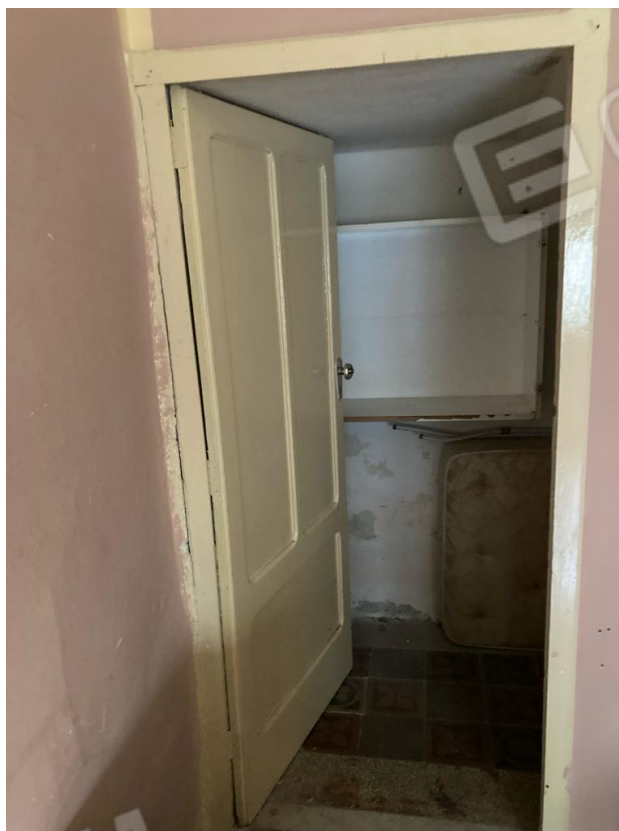
Ripostiglio piano primo
