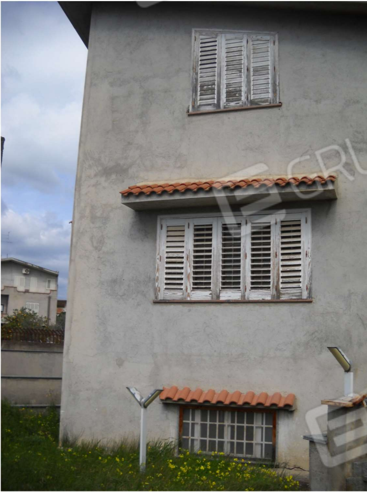
foto n. 1 – fabbricato particella 867 dalla corte
