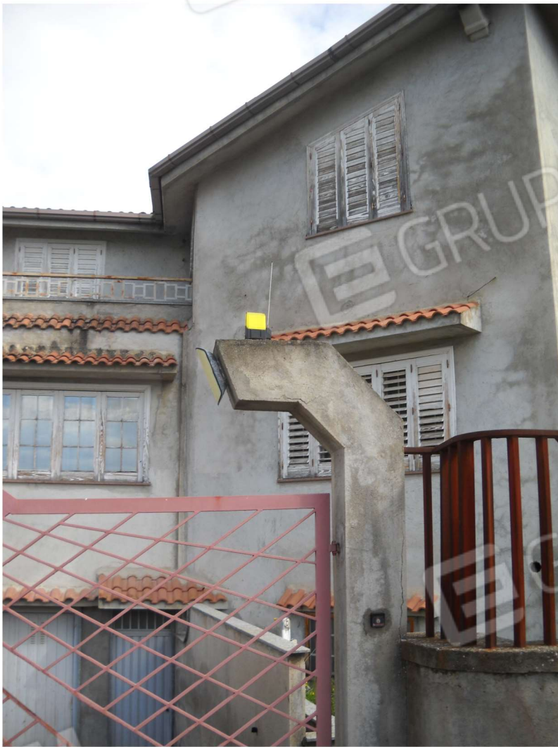
foto n. 3 – fabbricato particella 867 f. di m. 32 dalla rampa carrabile
