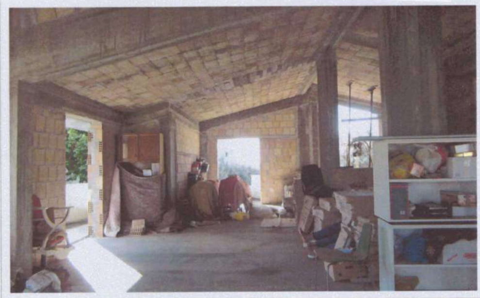
FOTO N°15 VISTE INTERNE ALL'UNITA' IMMOBILIARE AL PRIMO PIANO
