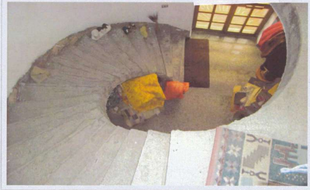
FOTO N°13 VANO SCALA DI ACCESSO AL PRIMO PIANO
