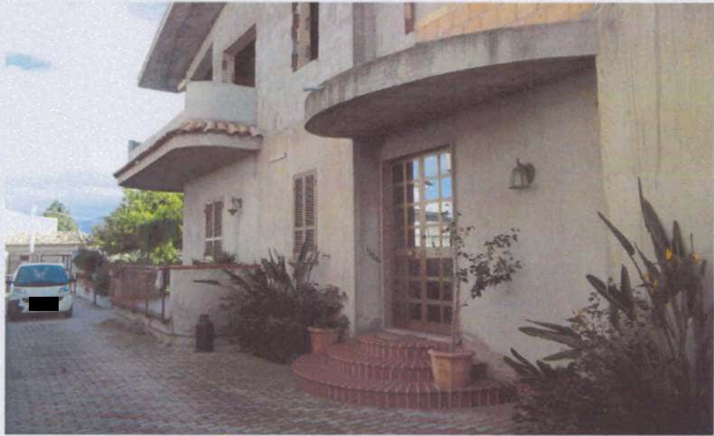
FOTO N°3 INGRESSO PRINCIPALE (LATO NORD)
