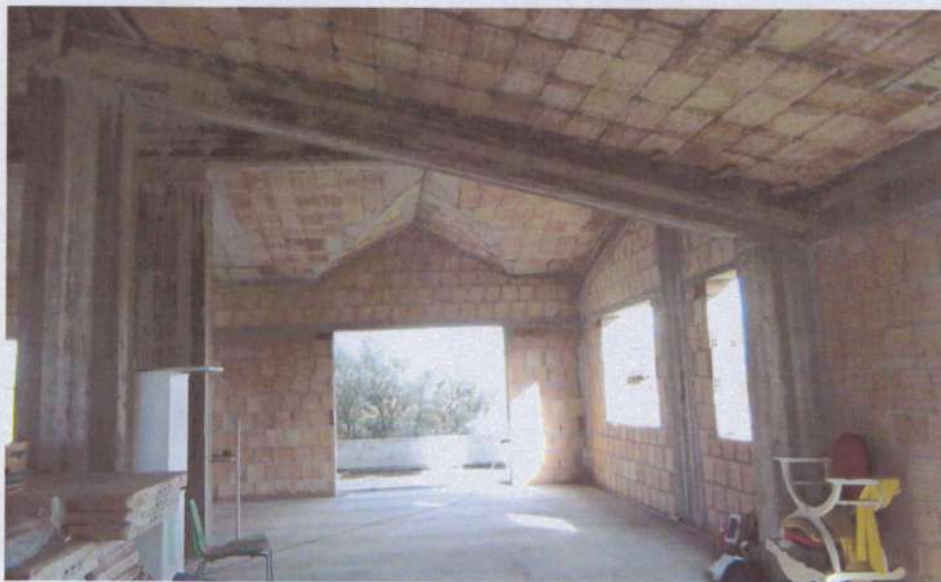
FOTO N°17 VISTE INTERNE AL PIANO PRIMO
