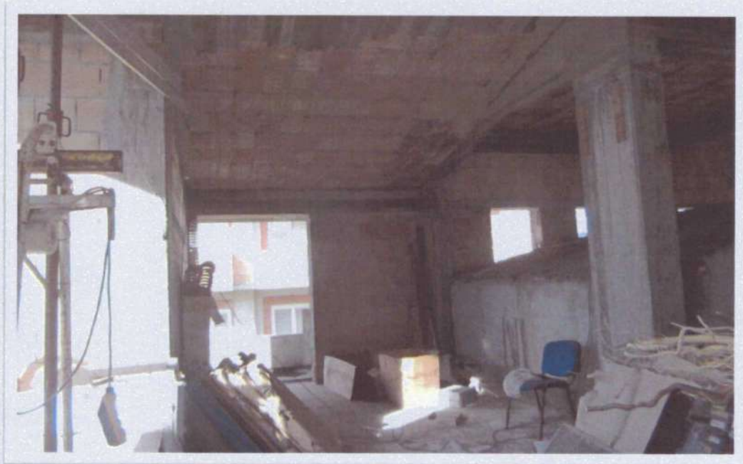
FOTO N° 14 UNITA' IMMOBILIARE PRIMO PIANO
