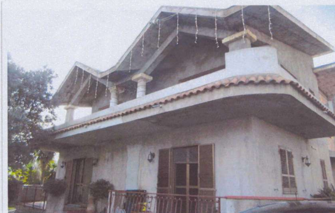
FOTO N°2 VISTA DI INSIEME DELL'IMMOBILE ( LATO OVEST)
