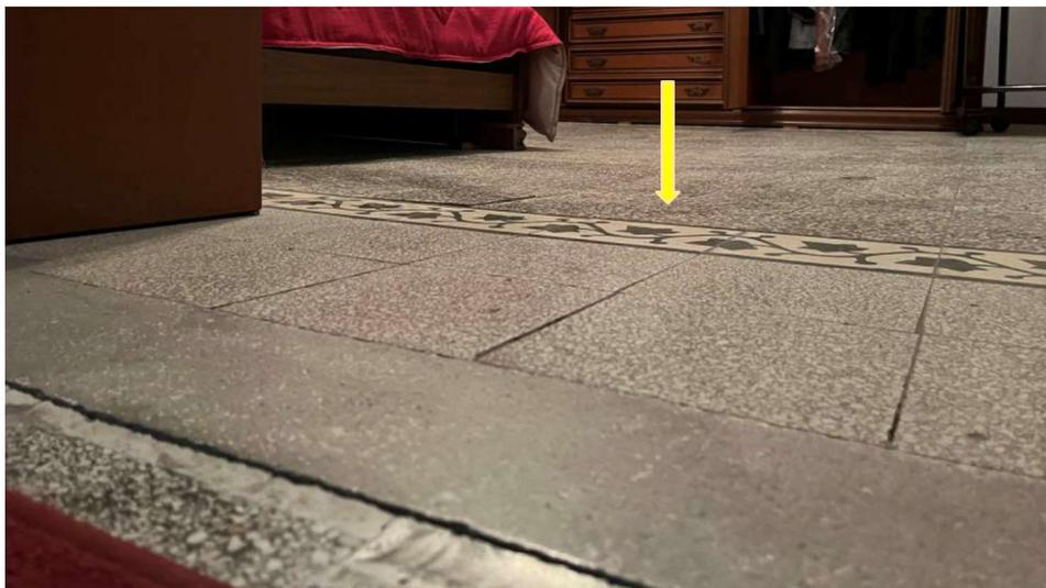
*FOTO 12. Particolare del pavimento della camera da letto al primo piano, con riferimento al cedimento*
