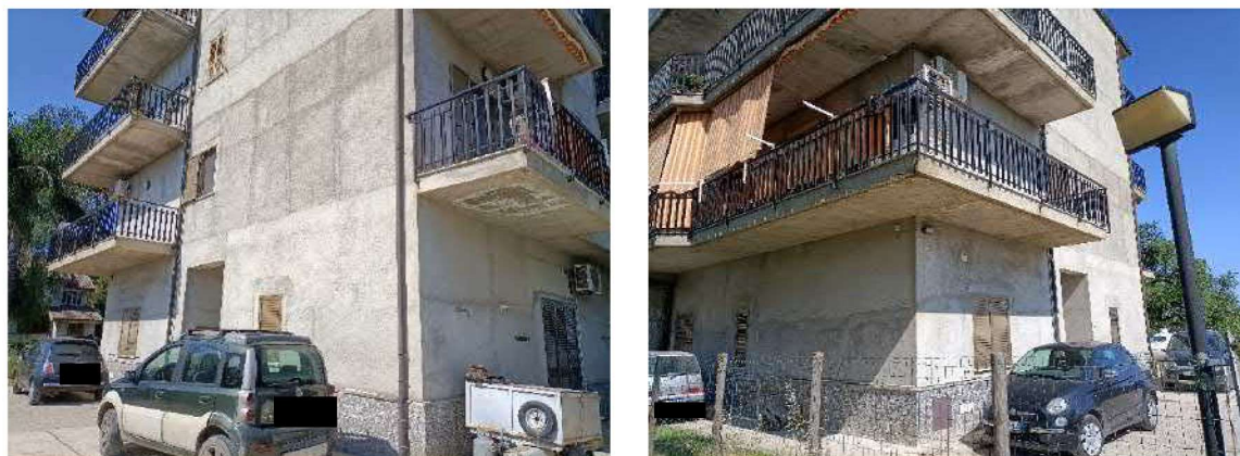
Foto 7 – 8 - Vista dal cortile di pertinenza Dell'immobile in Oggetto
