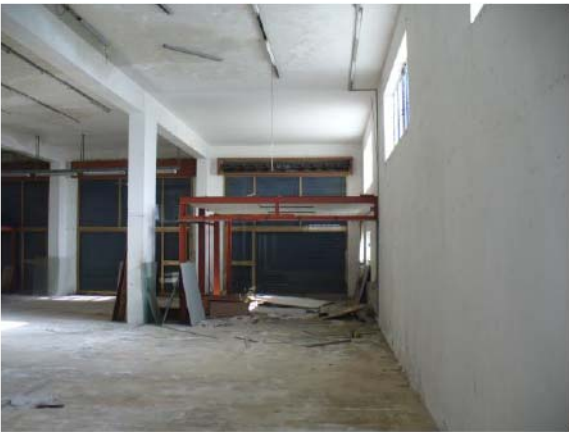
Foto n. 5 – interno piano terra –
