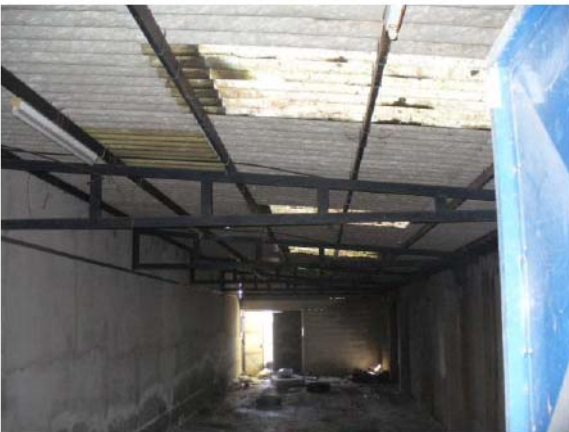
Foto n. 10 – interno corpo ad un piano f.t. –
