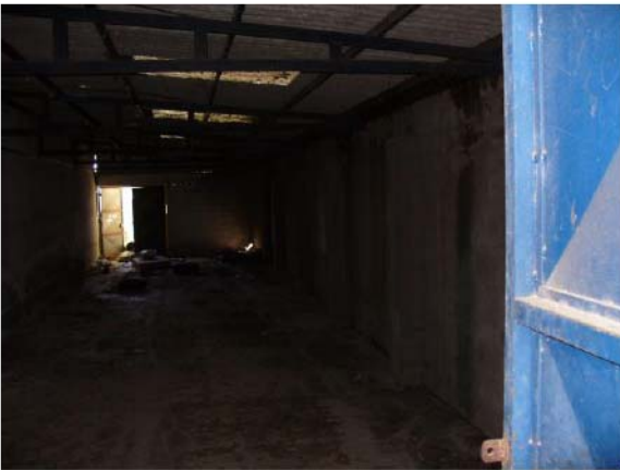
Foto n. 9 – interno corpo ad un piano f.t. –
