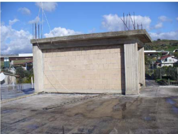
FOTO N. 17 – lastrico solare - abbaino –
