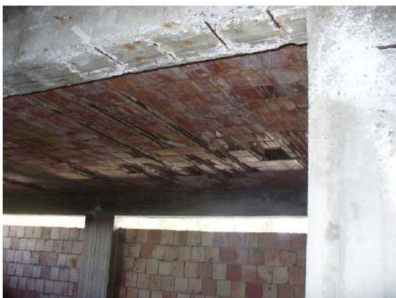
Foto n. 12 - particolare solaio piano primo –
