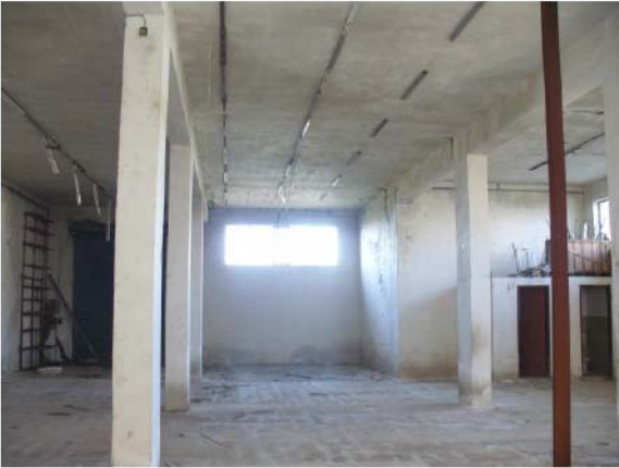
Foto n. 4 – interno piano terra –
