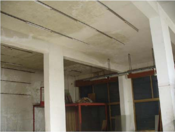
Foto n. 8 – interno piano terra – solaio –
