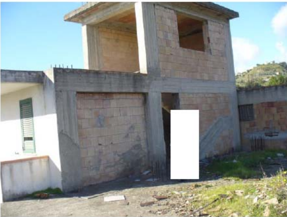
FOTO N. 15 – copertura frantoio - accesso pianerottolo P.1–
