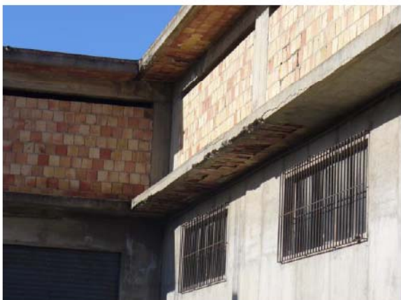
Foto n. 3 – particolare infisso e struttura balcone –
