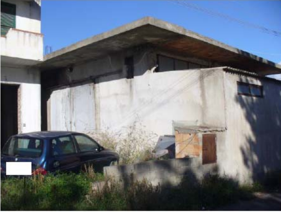
FOTO N. 14 – corpo di fabbrica destinato a frantoio –
