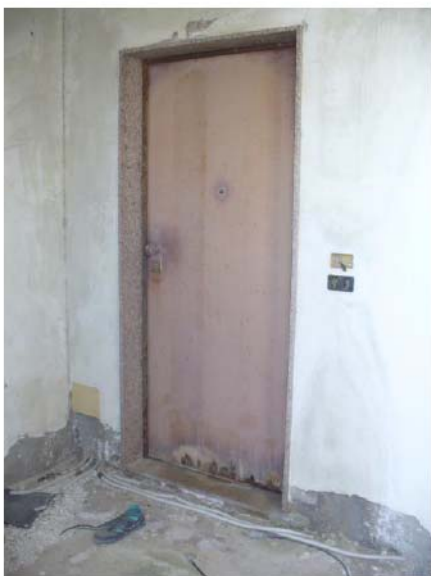
FOTO N. 18 – portone accesso appartamento piano primo –
