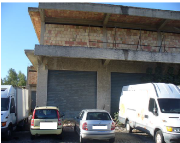
Foto n. 1 – prospetto lato strada -
