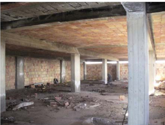
Foto n. 11 - interno piano primo –
