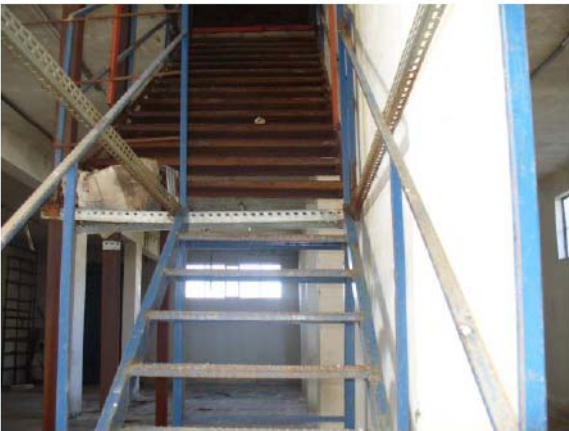
Foto n. 6 – interno piano terra – scala in metallo –
