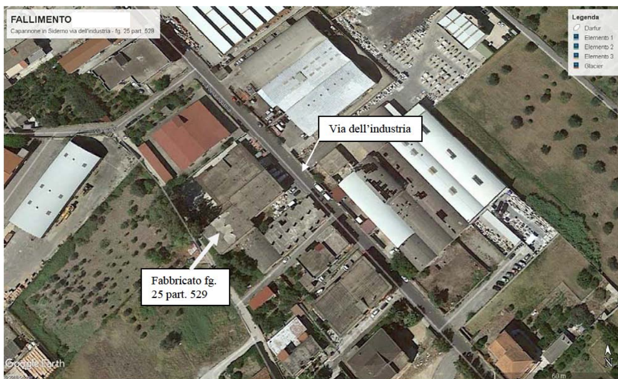
FOTO AEREA N. 1 – Fabbricato fg. 25 part. 529 – località Pantanizzi – via dell'Industria –
