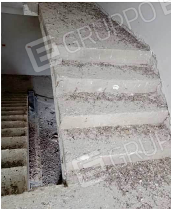
FOTO 17 ACCESSO AL PRIMO PIANO
