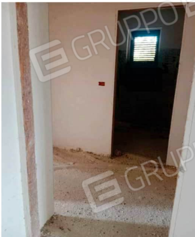
FOTO 13 INGRESSO UNITA' B
