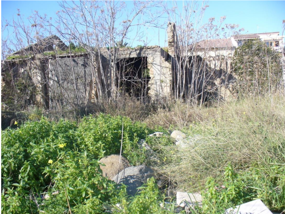
FOTO AEREA N.11 – rudere fg 34 part. 177 sub 1-
