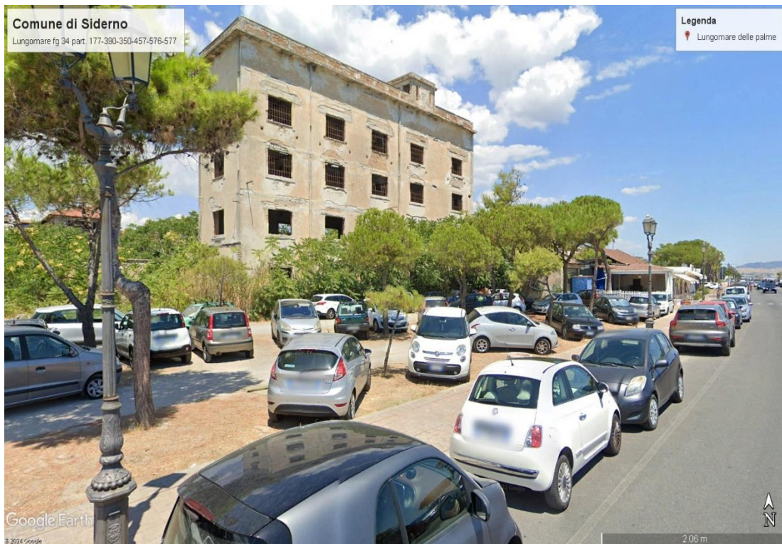
FOTO AEREA N.10 – rudere fg 34 part. 390 sub 1
