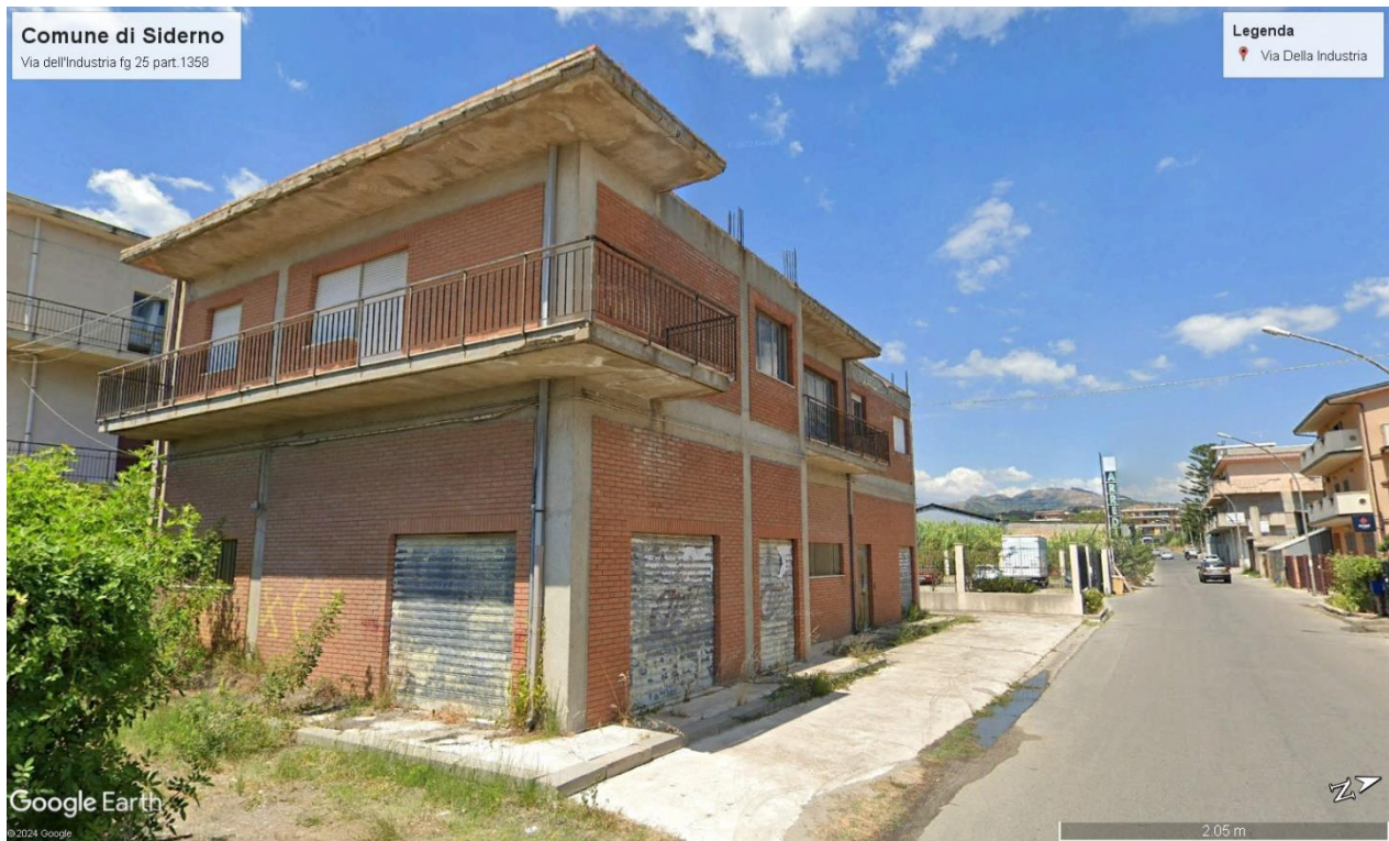
FOTO AEREA N.8 – fabbricato fg 25 part. 1358-
