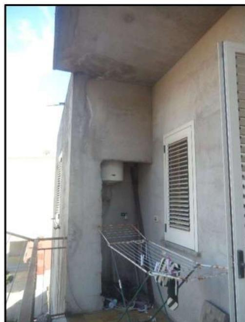
Tutti i vani dell'immobile presentano notevoli macchie di muffa nera sulle pareti verticali e sul soffitto, inoltre in molti punti della casa si notano fessurazioni dovute al distacco dell'intonaco e/o al movimento tra i mattoni forati e i pilastri e le travi.
