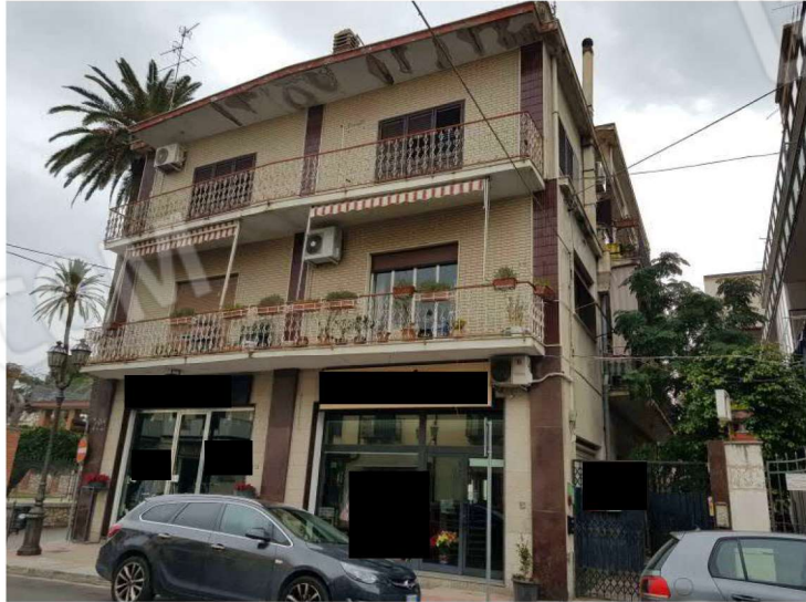
Foto 1) prospetto lato corso della repubblica
