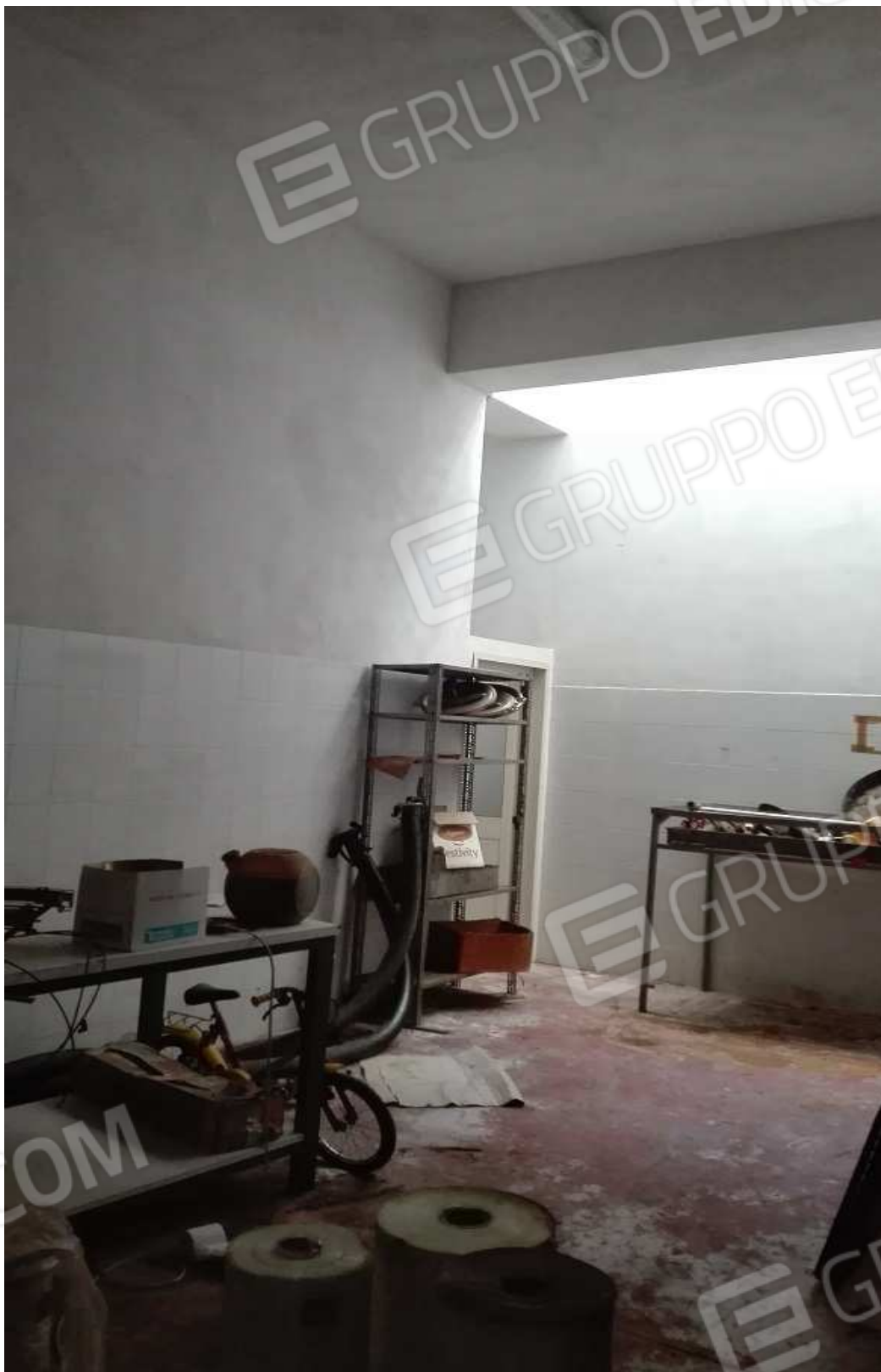
veduta della superficie interna
