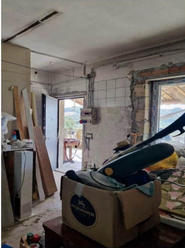
Foto n. 13 –interni porzione unità sub 10-
