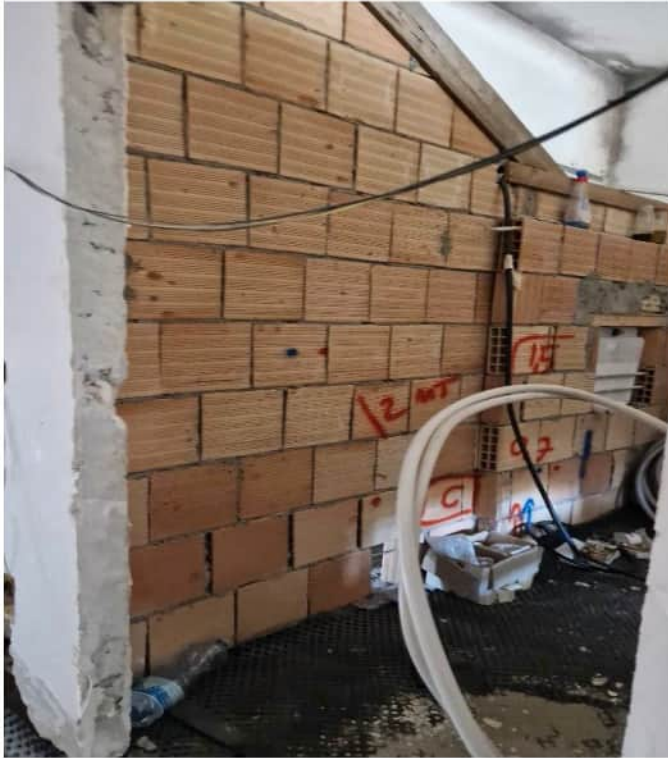
Foto n. 11 –interni unità sub 9-
