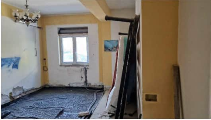
Foto n. 8 –interni unità sub 9-
