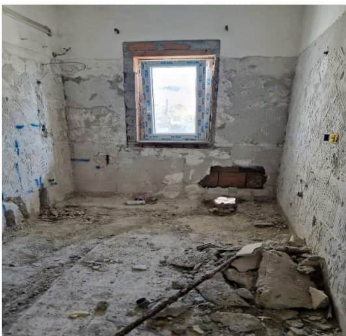
Foto n. 7 –interni unità sub 9-
