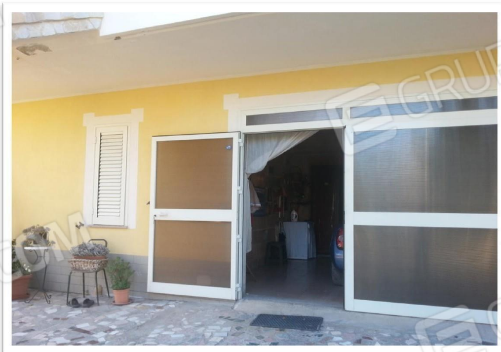
FOTO N°4 INGRESSO PIANO SEMINTERRATO
