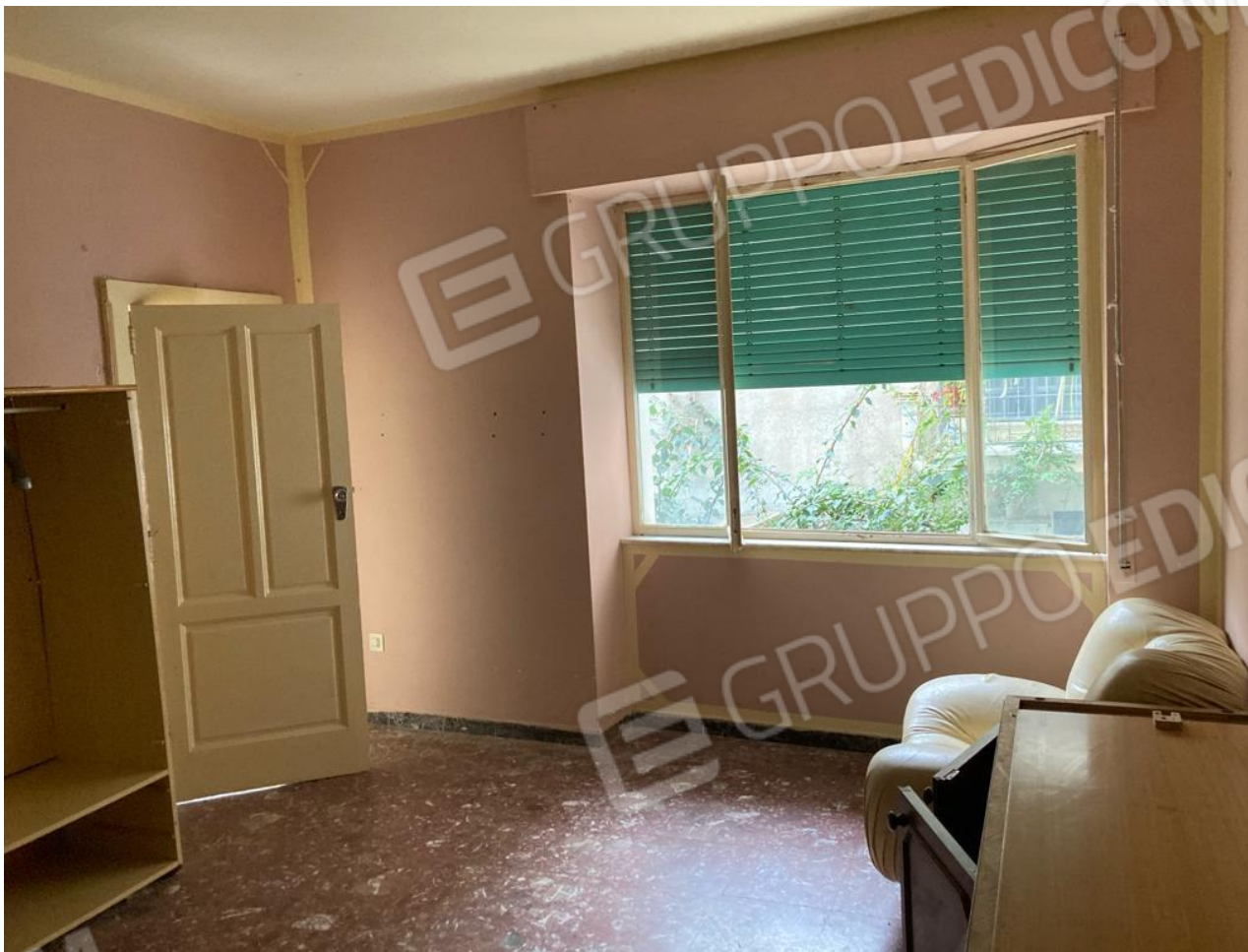
Vano piano primo
