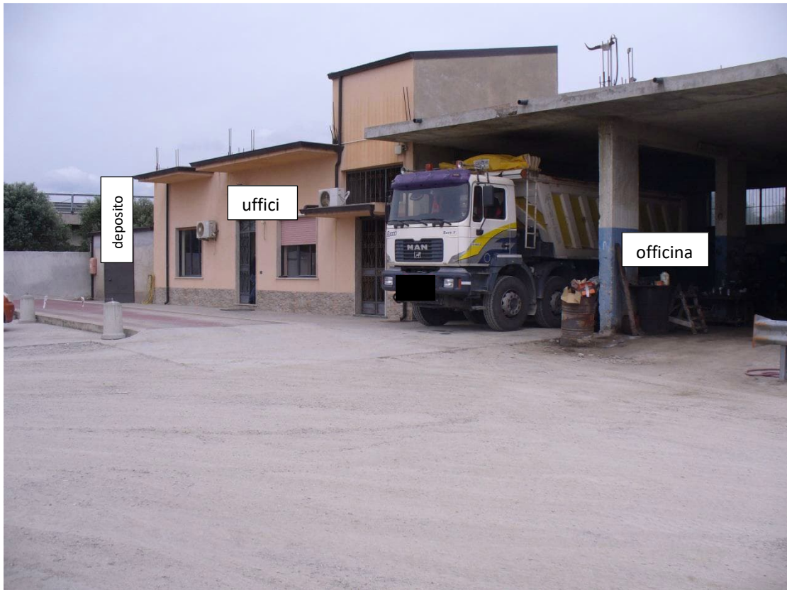
FOTO N. 1 – Complesso Uffici-officina – deposito –
