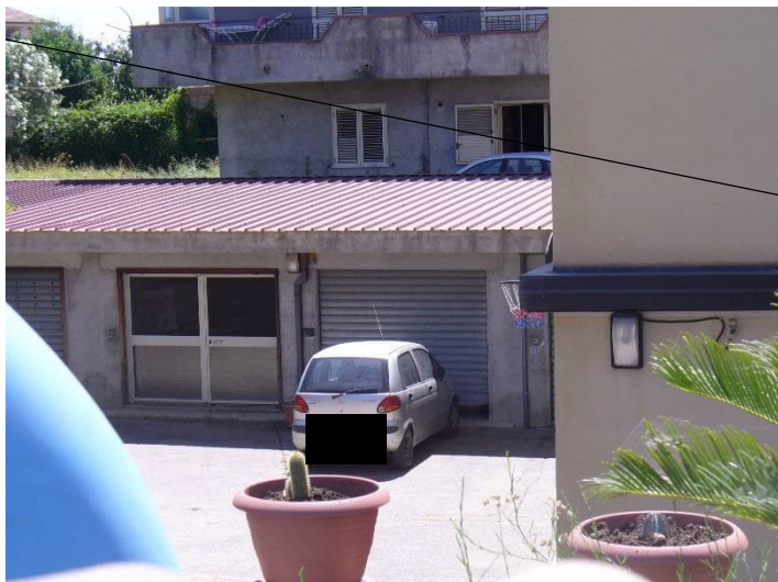
FOTO N. 52– Ingresso al garage –
