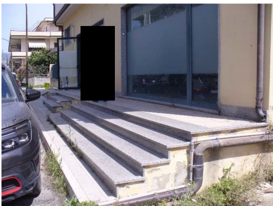
FOTO N. 44– accessi da via Circonvallazione Nord –
