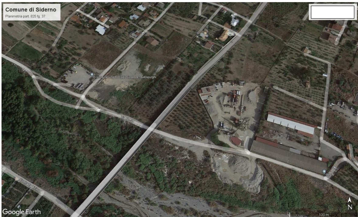
FOTO AEREA N. 2 – impianto -
