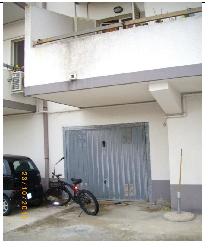
Vista esterna con apertura basculante del Box Auto al piano seminterrato posto sotto dell'appartamento.
