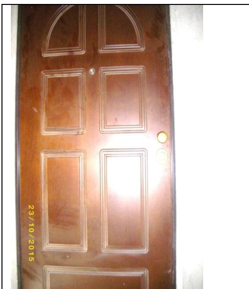
particolare del piano mansardato ( portone)
