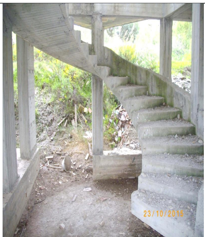
particolare della scala ellissoidale di collegamento tra (PT/P1°) e dell'ingresso principale
