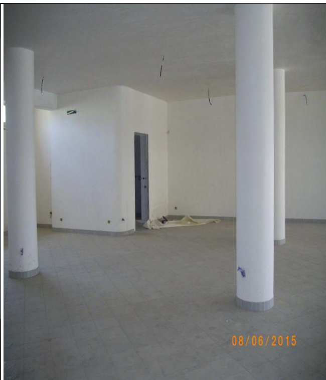
Veduta Interna del bene eseguito NOTARE CHE NON C'E' divisione con il sub. adiacente di cui è parte il bagno sullo sfondo , notare ancora i particolari della finitura e dell'impiantistica
