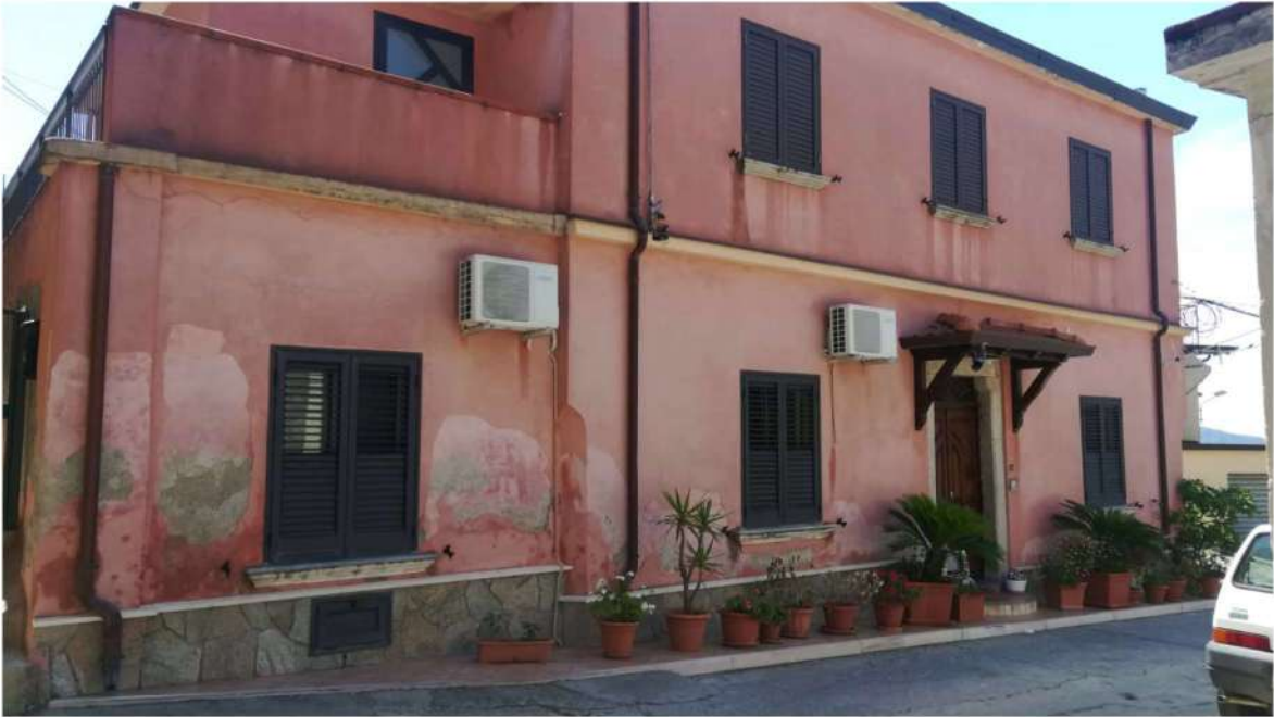
Foto particella 15 sub 1 al 16/06/2022
