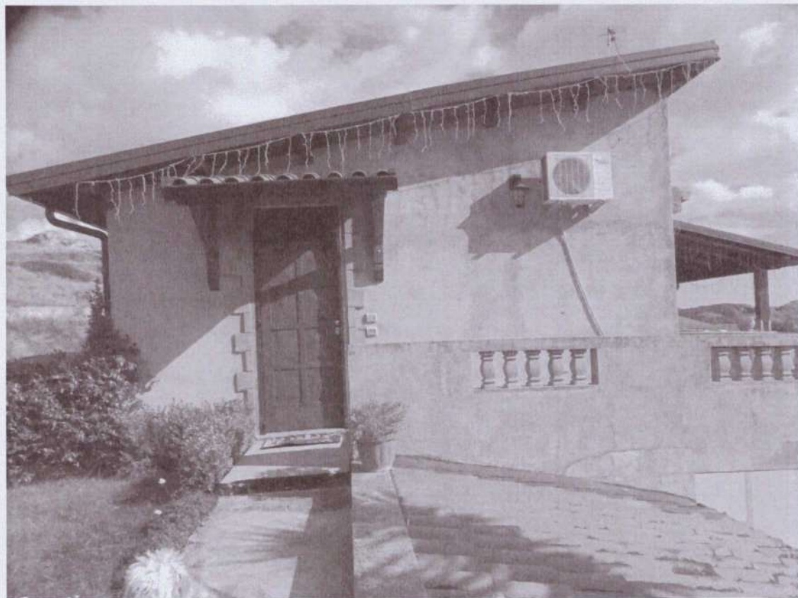
Foto 14. Piano primo – Portone d'ingresso all'abitazione.
