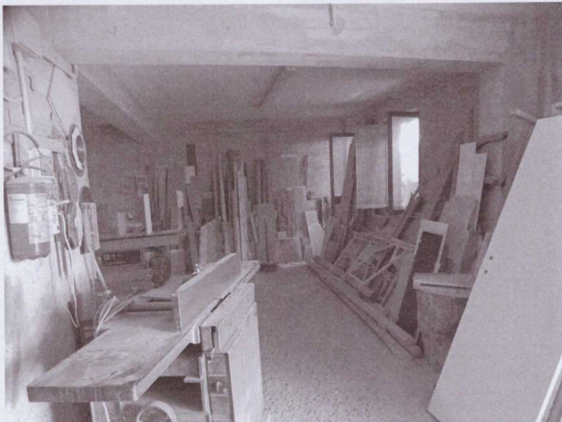
Foto 7. Piano terra – Deposito - laboratorio
