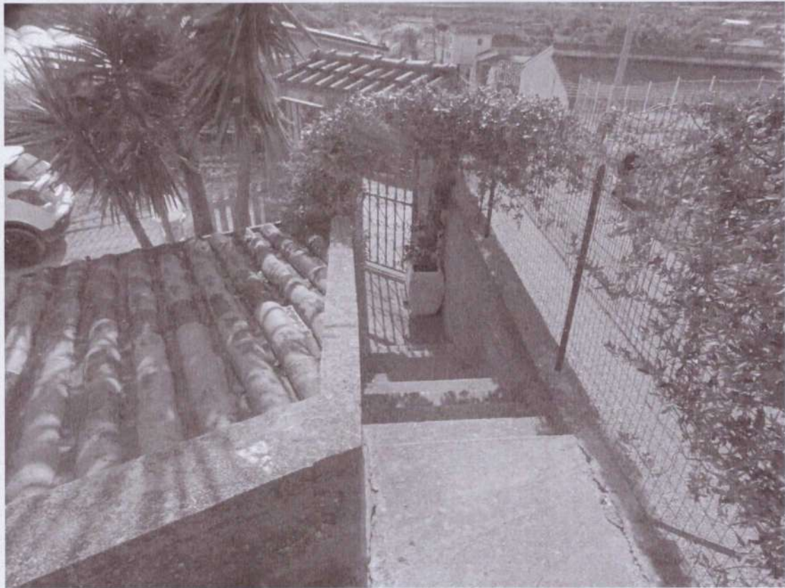
Foto 13. Piano terra – Scala esterna di accesso al piano primo
