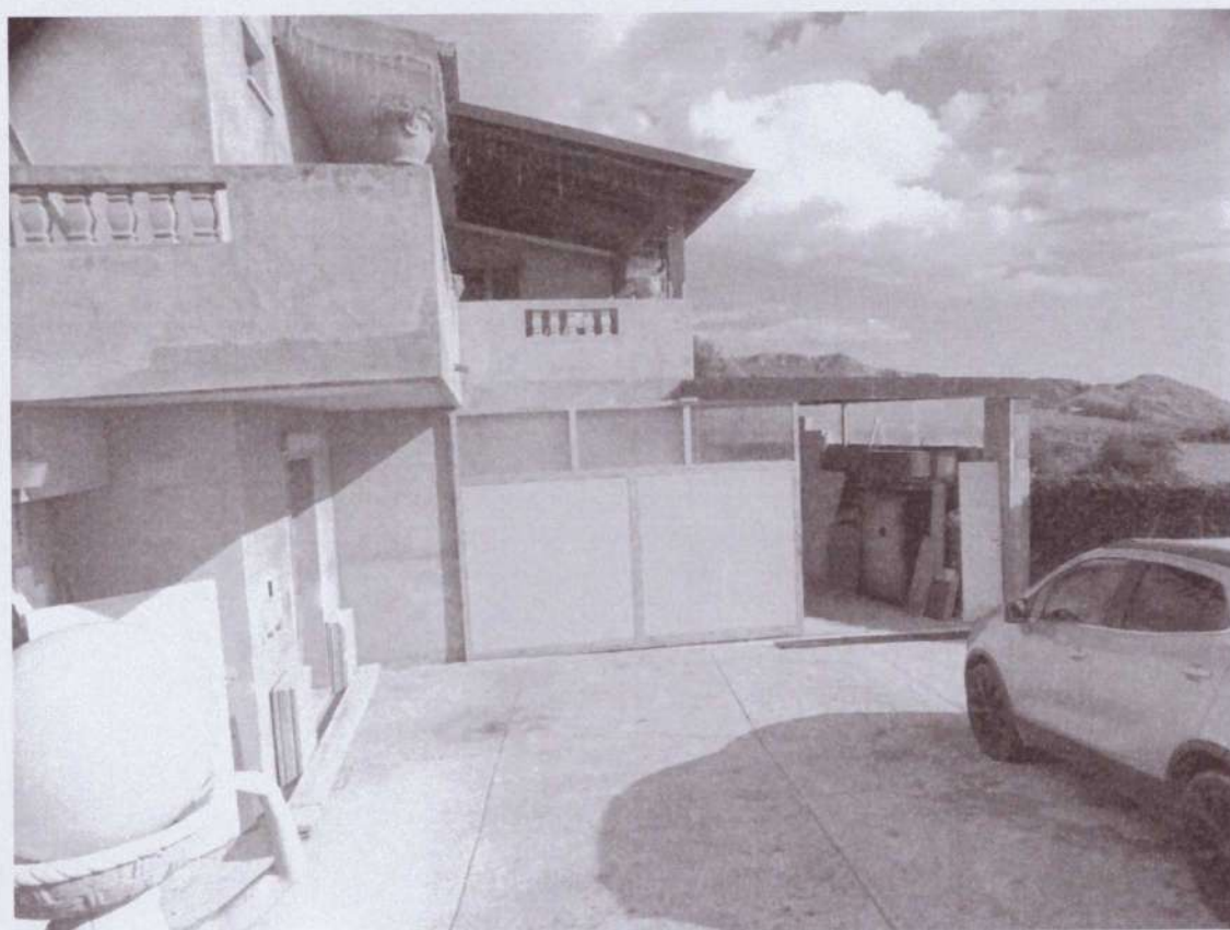
Foto 4. Piano terra - Piazzale
