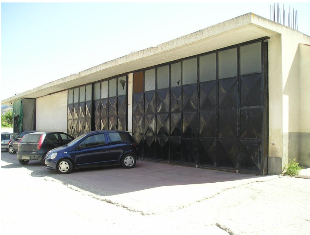
FOTO N. 4 – lato ingressi fabbricato “A” –
