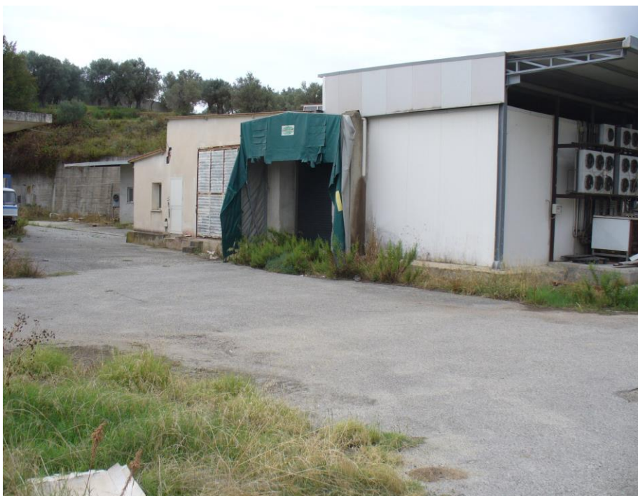
FOTO N. 11 – fabbricato "B" - prospetto sul piazzale -
