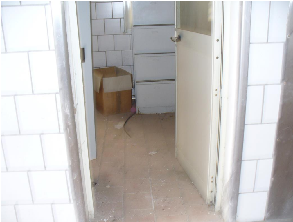
FOTO N. 14 – interni - fabbricato “B”-
