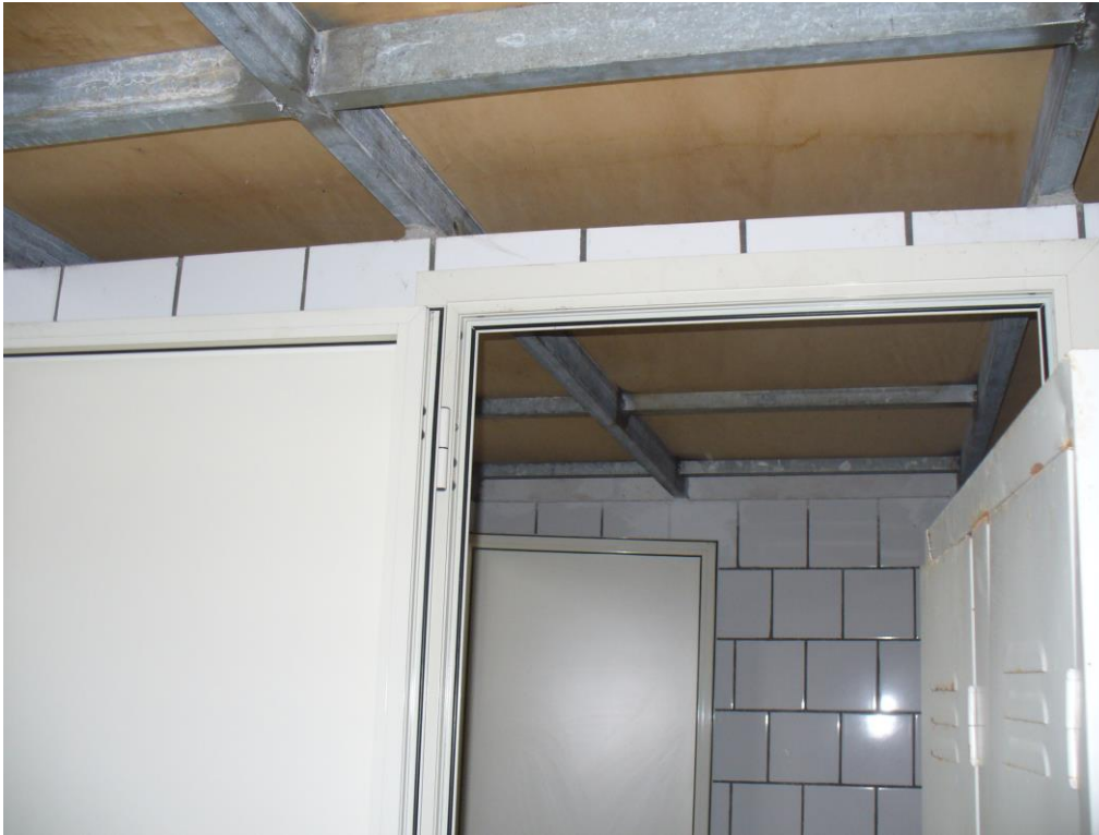
FOTO N. 9 – struttura del soppalco-
