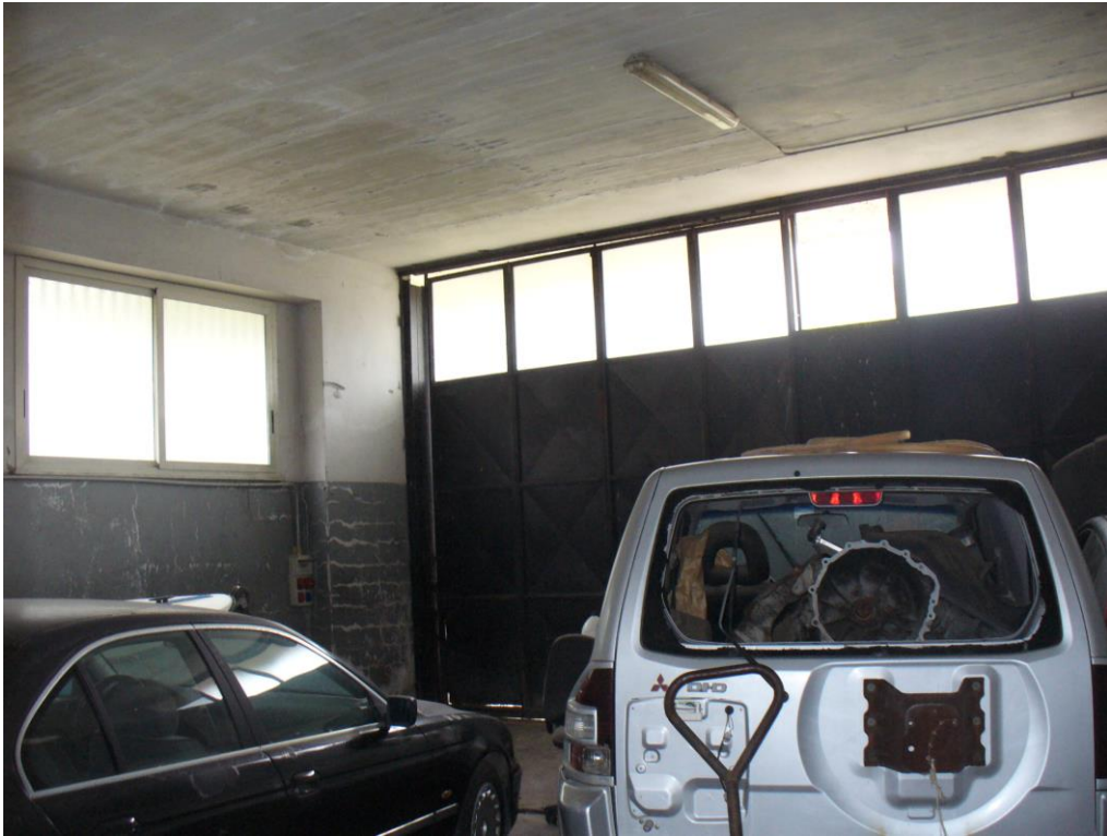
FOTO N. 7 – interno del fabbricato “A” – porta di accesso vista dall’interno-
