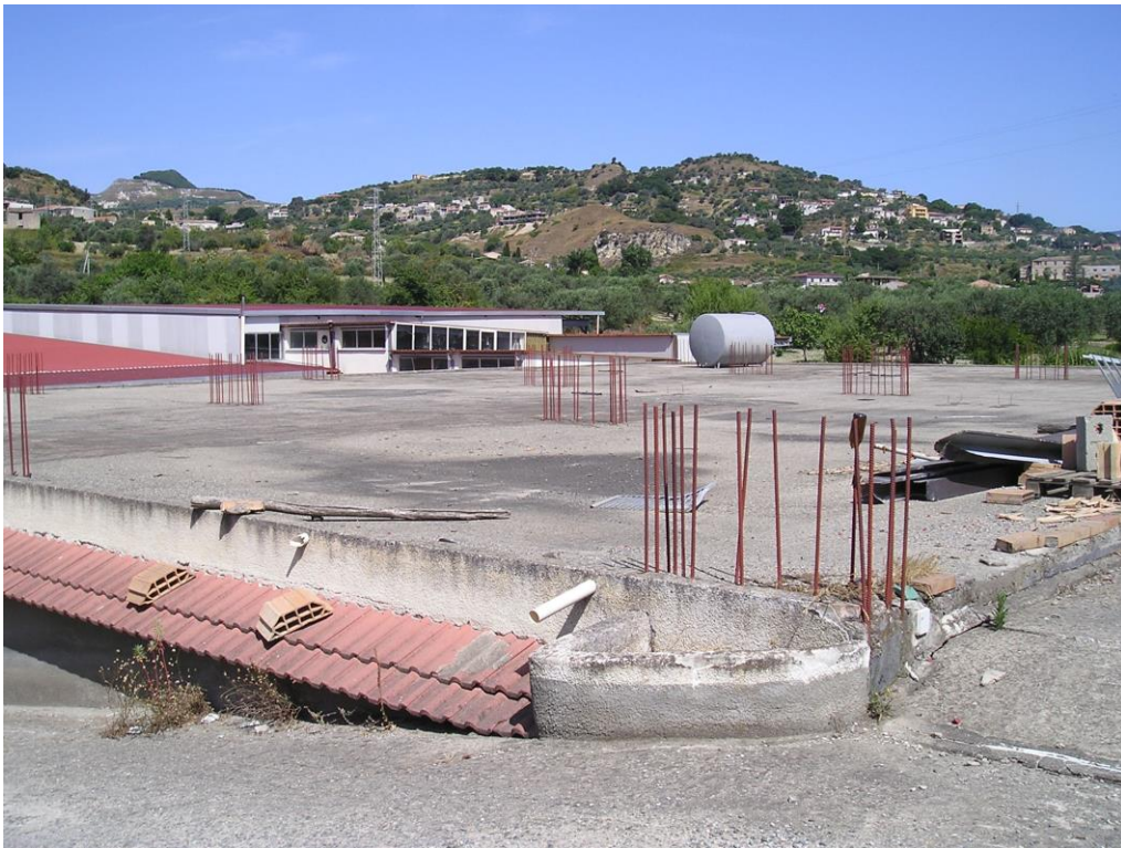
FOTO N. 6 – solaio di copertura fabbricato "A"
