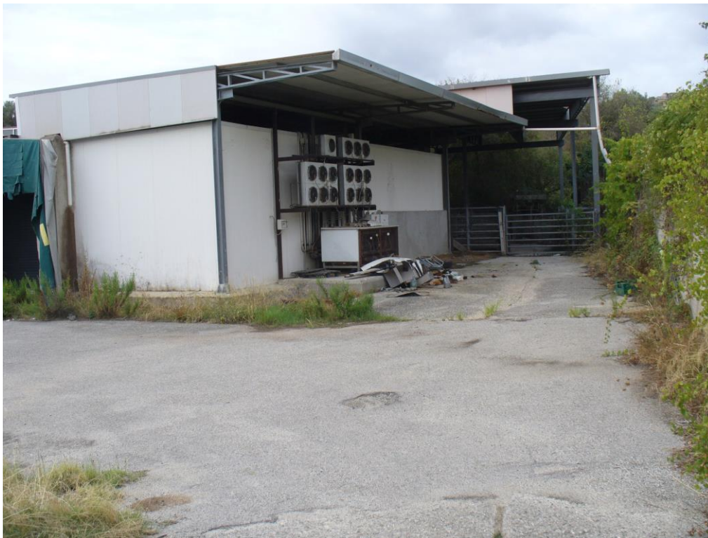
FOTO N. 15 – piazzale e tettoia –
