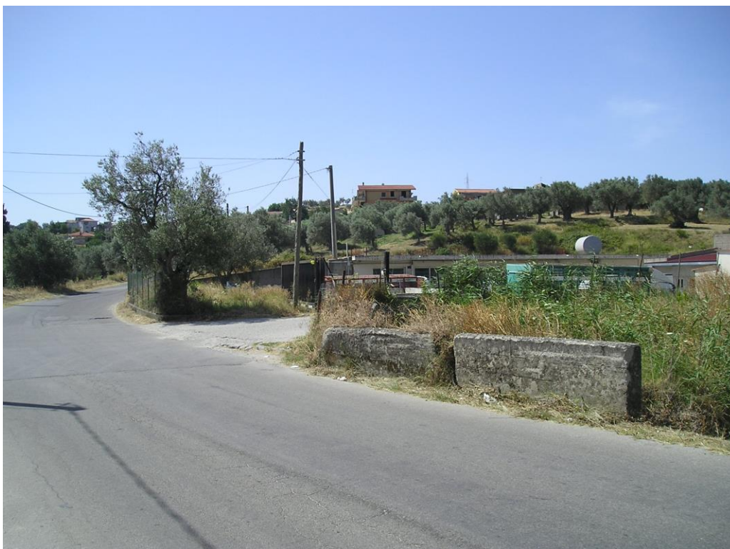
FOTO N. 1 – accesso al complesso di lavorazioni carni -lato monte –
