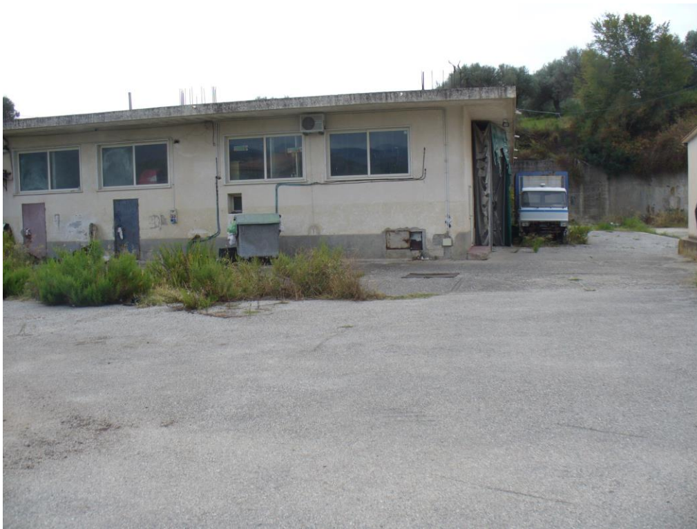
FOTO N. 3 – prospetto lato monti fabbricato “A” –
