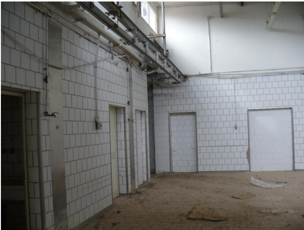
FOTO N. 13 – interni - fabbricato “B”-
