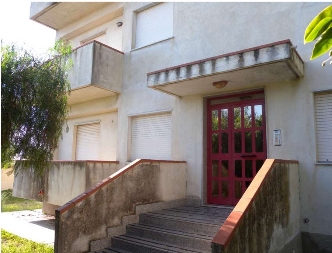
Foto n. 2 Vista portone ingresso scala condominiale
