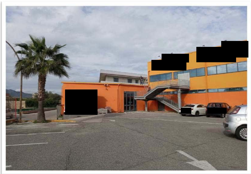
FOTO2 Area esterna lato rampa di accesso al Capannone ARCH. LUCIA SACCA' - CTU -
