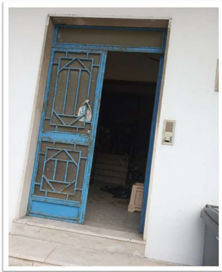
FOTO 1 Ingresso su Corso Vittorio Emanuele (SS 106)
