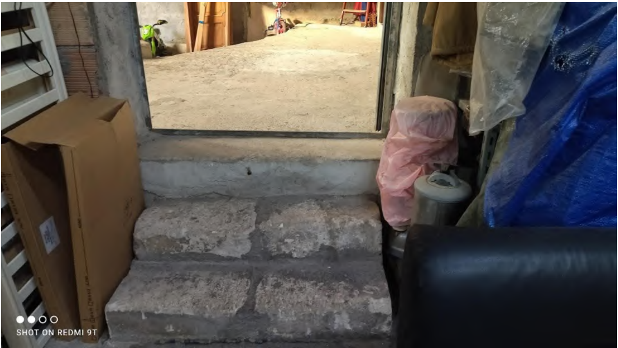
Particolare ingresso interno androne
