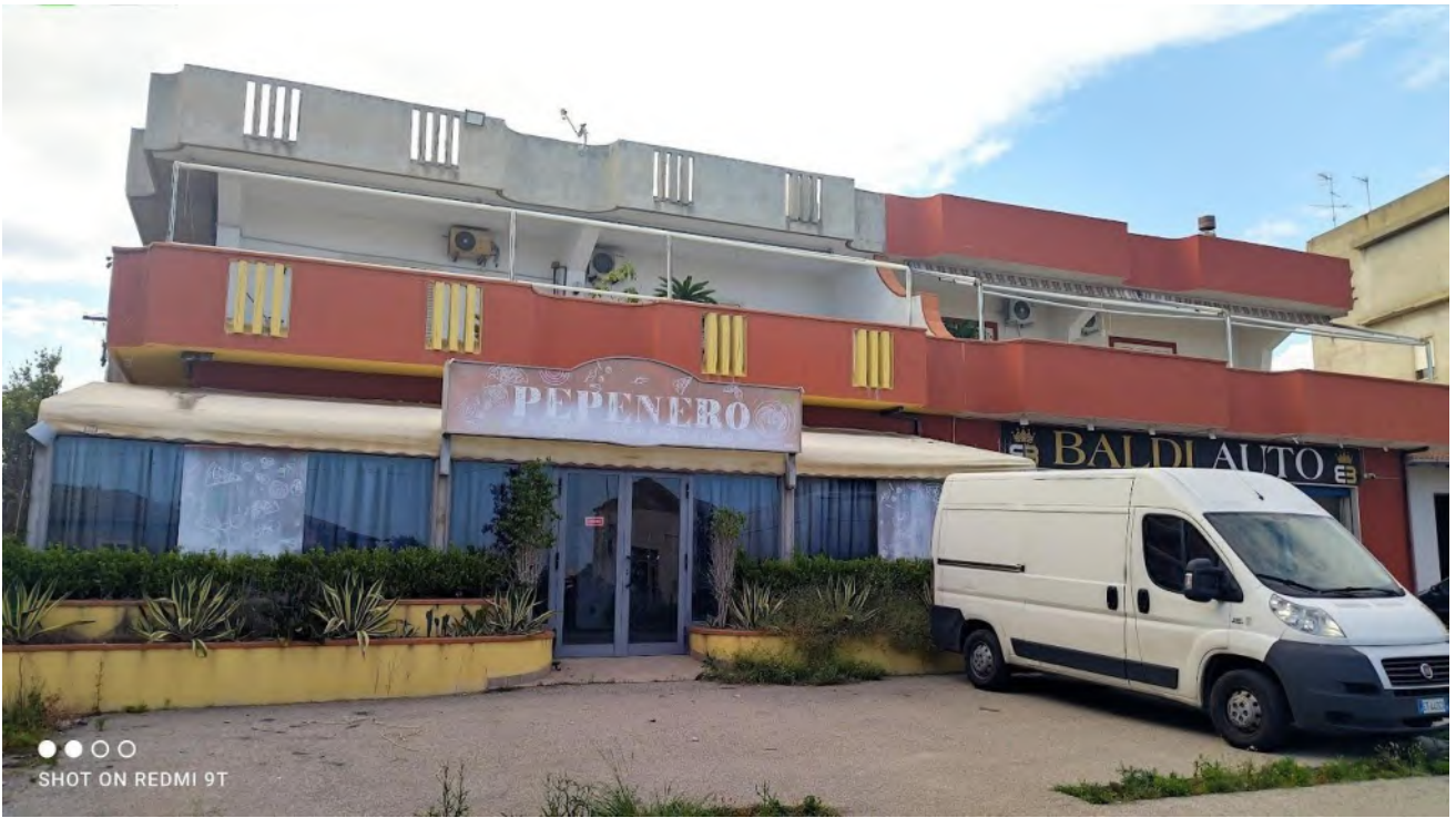
FABBRICATO PROSPETTO LATO STRADA NAZIONALE 106
