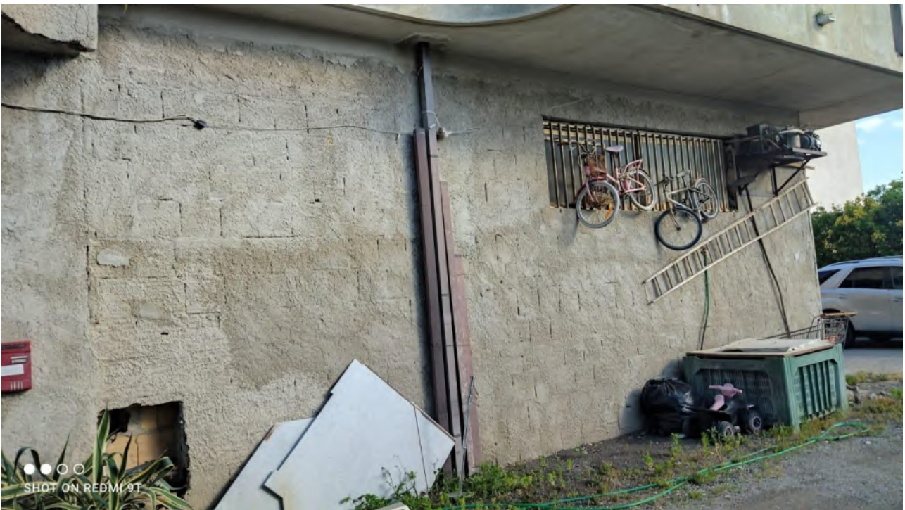
Particolare parete con finestrone
