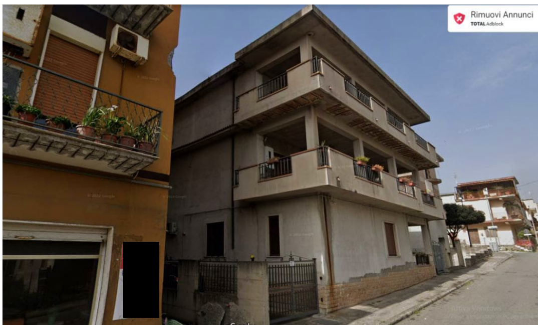
Vista fotografica prospetto laterale, lato mare, (Google Maps) - Comune Bianco, Via D. Salvadori, 25
