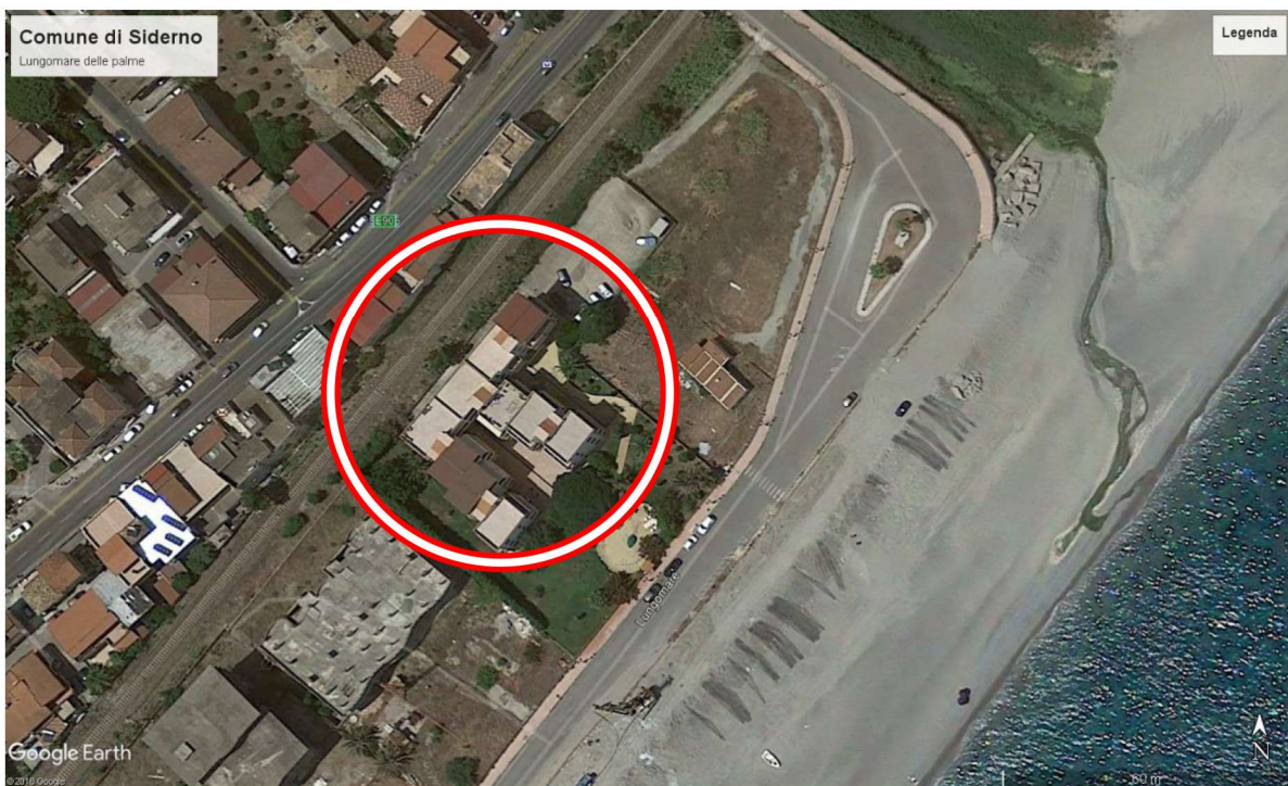
FOTO AEREA n.5 – complesso via Lungomare delle Palme –
