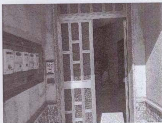
5.Portone di Ingresso al Fabbricato
