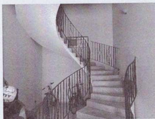
6.Androne di Ingresso
