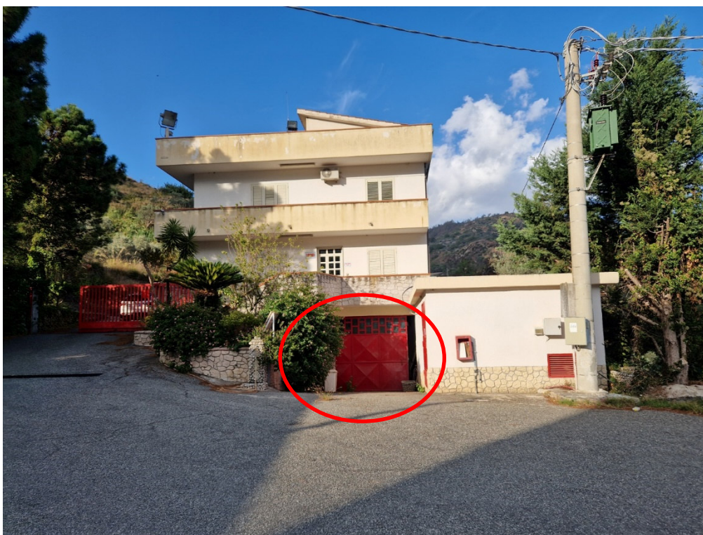
Foto 7 – Chiusura portico dell'edificio adibito ad ufficio
