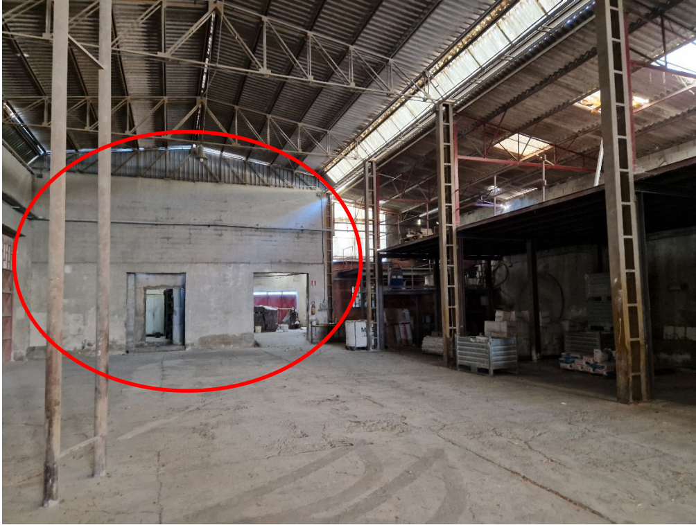
Foto 3 – Spazio retrostante il capannone vecchio, un tempo destinato alla lavorazione del marmo
