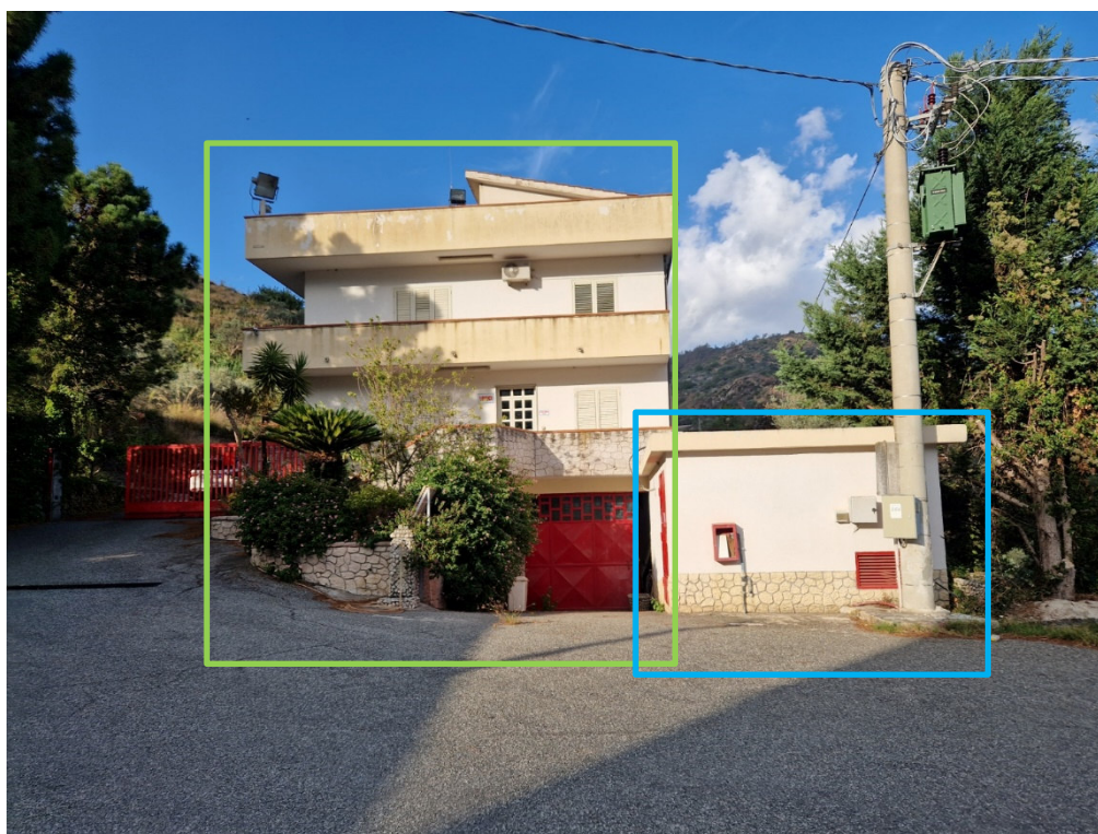
Foto 5 – Fabbricato destinato ad ufficio/laboratorio e cabina elettrica
