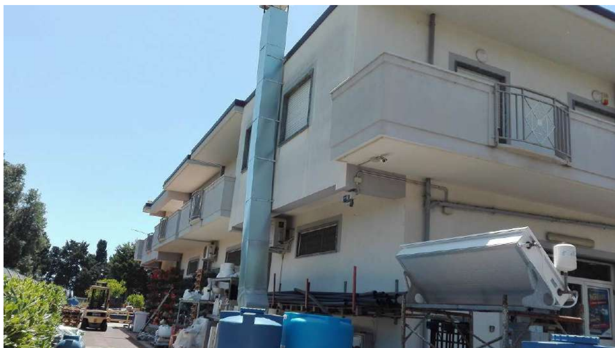
il corridoio carrabile di accesso – lato nord
