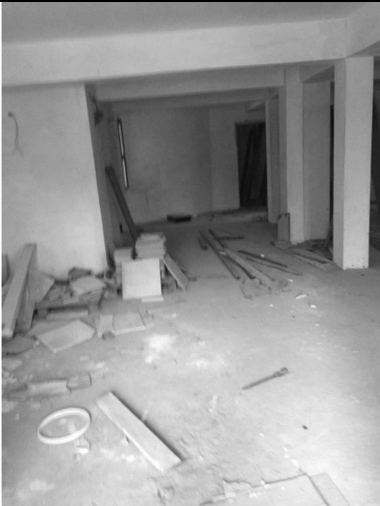
Open space – vista verso interno
