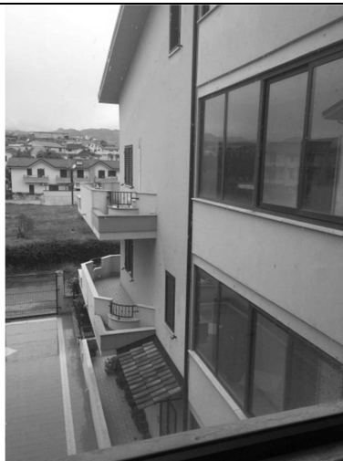
Ballatoio con vista lato nord
